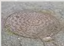
Regard d'eaux usées
