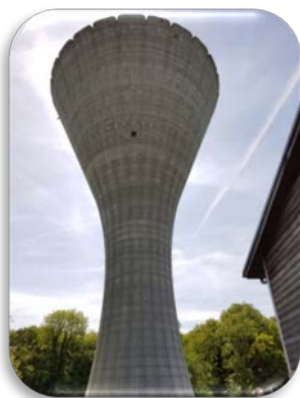
Photo 1 : Château d'eau de Labryère
