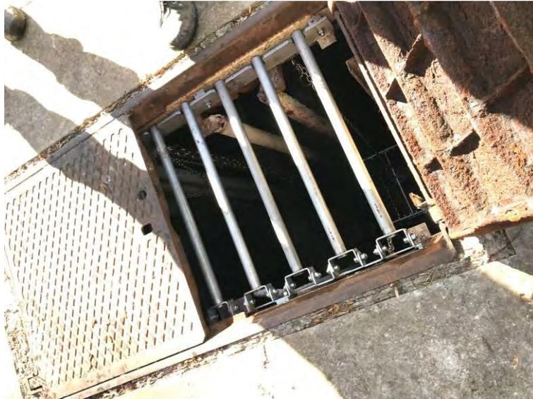
Installation de barreaux anti-chutes sur le PR Marais à Rosoy
