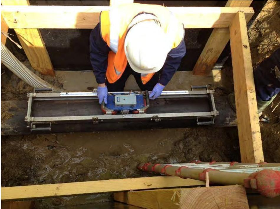
Figure 52 : Scan de la canalisation
