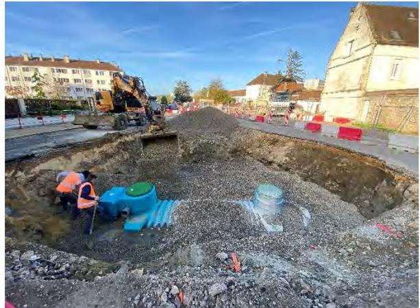
Figure 112 : **Récupérateur d'eaux pluviales** – Place Chanoine Snejdareck à Liancourt (DEGAUCHY)
