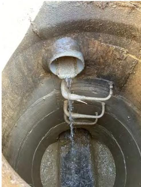
Figure 110 : **Création d'un trop-plein d'eaux pluviales – Rue du château d'eau à Mogneville (DMVA)**
