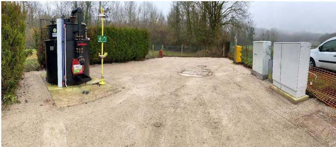
Figure 153 : Traitement anti H<sub>2</sub>S du PR PONCEAU à Verderonne
