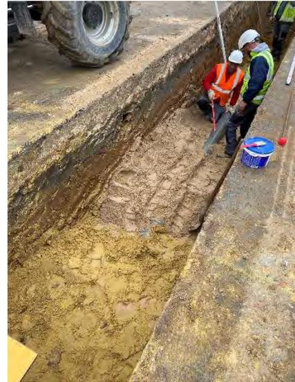
Figure 114 : **Pose du réseau d'eaux usées** – Avenue du Général de Gaulle à Liancourt (DEGAUCHY)
