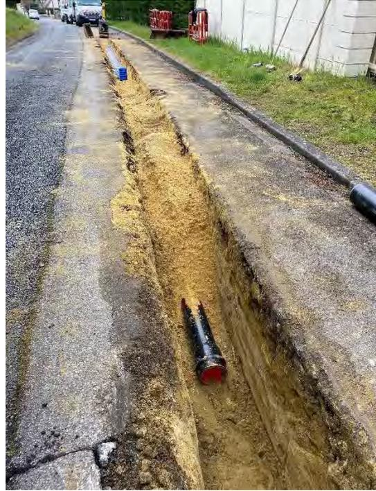
Figure 45 : Renouvellement **de la conduite et des branchements d'eau potable** – Rue Emile Lambert à Mogneville (Régie CCLVD)
