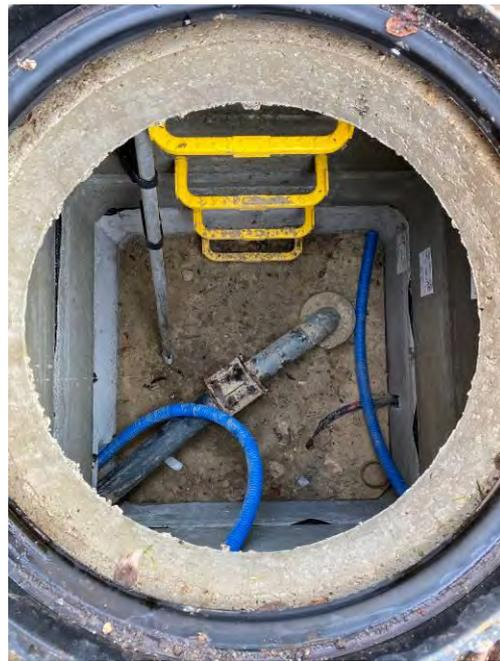
Figure 152 : Traitement anti H<sub>2</sub>S du PR MARAIS à Labruyère
