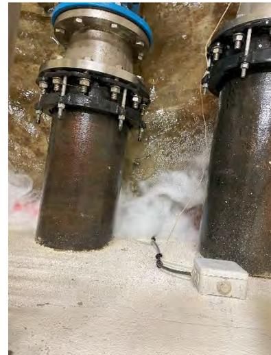
Figure 37 : Fuite sur la conduite d'alimentation des semi-enterrés (10 octobre 2023)
