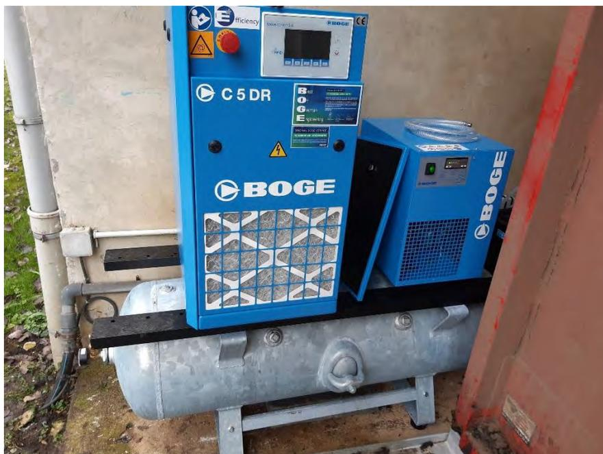
Figure 169 : Compresseur à air comprimé pour les boues (VEOLIA)
