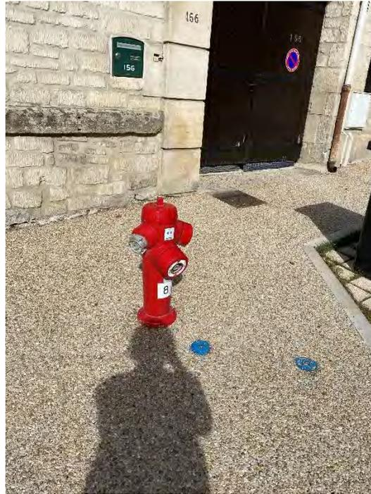
Figure 64 : Renouvellement **d'un poteau d'incendie** LAI 8 – Rue de la République à Laigneville (OISE TP)
