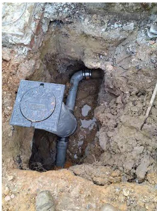
Figure 134 : Exemple de branchement réalisé par DMVA
