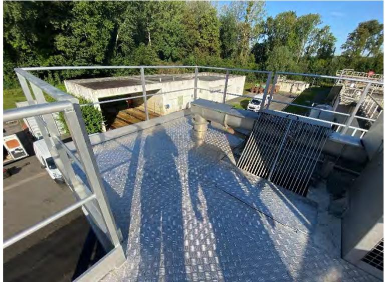
Figure 165 : Plate-forme d'accès au dégrilleur (VEOLIA)
