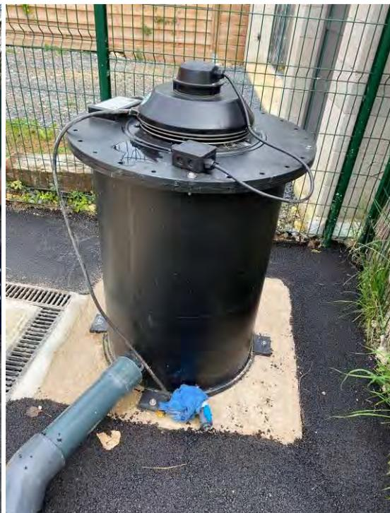
Figure 151 : Désodorisation du PR THEBAULT à Laigneville
