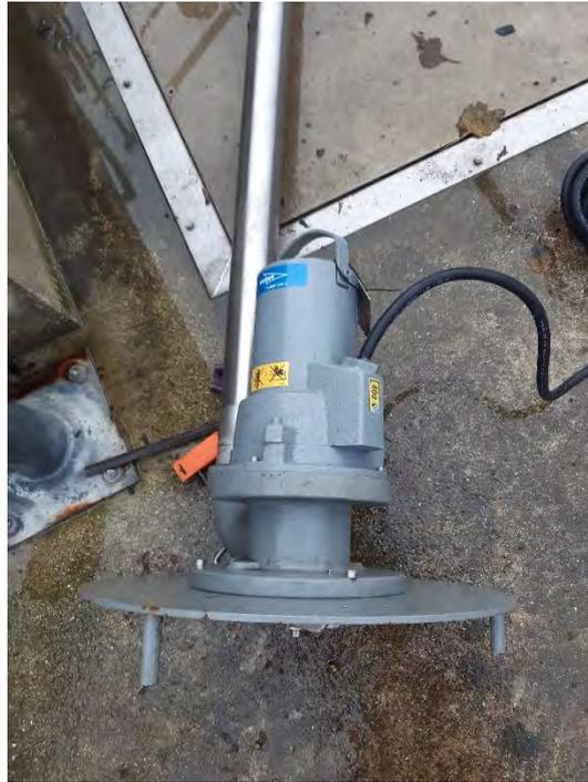
Figure 167 : Aéroflot du dégraisseur (VEOLIA)
