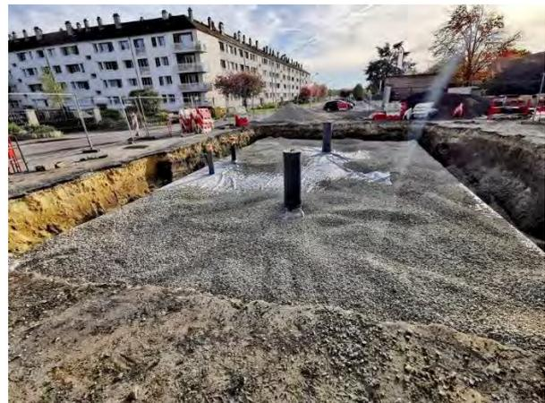
Figure 111 : **Caisiers d'infiltration des eaux pluviales– Place Chanoine Snejdareck à Liancourt (DEGAUCHY)**
