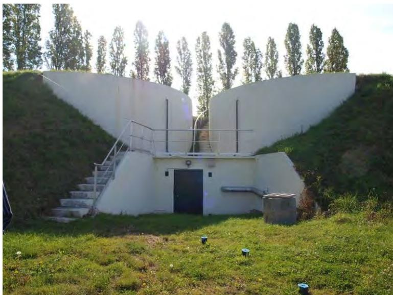
Figure 35 : Réservoirs semi-enterrés de Liancourt (2 x 750 m<sup>3</sup>)
