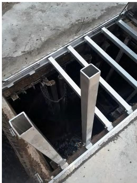
Figure 143 : Renouvellement de la trappe avec barreaux anti-chutes et aménagement devant le PR « MARAIS » à Rosoy (DMVA)
