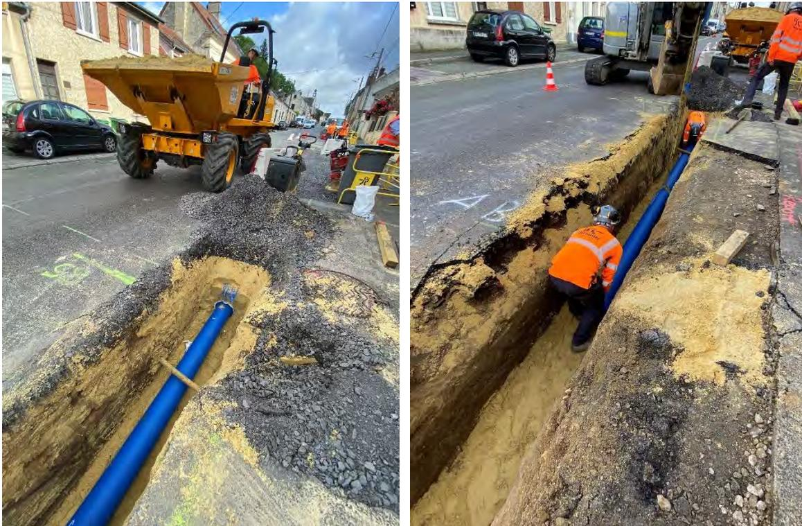
Figure 47 : Renouvellement de **la conduite et des branchements d'eau potable** – Rue de la République à Laigneville (OISE TP)
