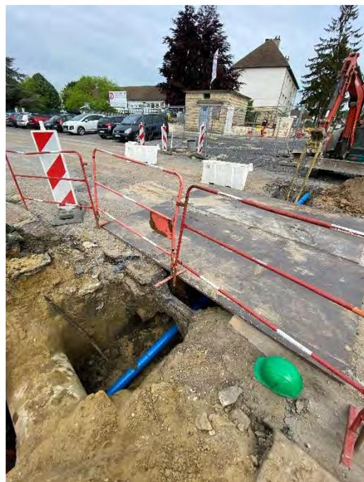
Figure 46 : Renouvellement de la conduite et des branchements **d'eau potable** – Avenue du général de Gaulle à Liancourt (DEGAUCHY / CAGNA)
