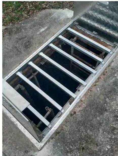
Figure 139 : Renouvellement des trappes avec barreaux anti-chutes sur le PR « ZA » à Cauffry (VEOLIA)
