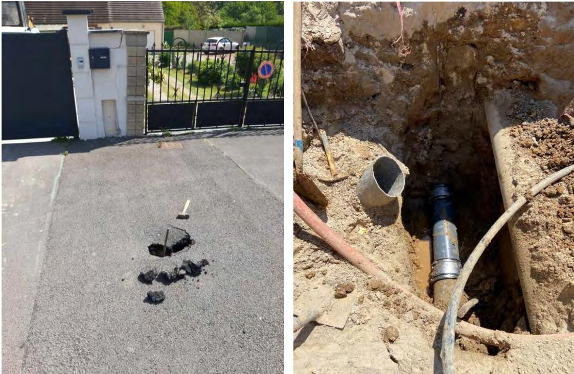
Figure 122 : **Réparation du réseau d'eaux pluviales** - Avenue Pierre Curie à Rantigny (DMVA)
