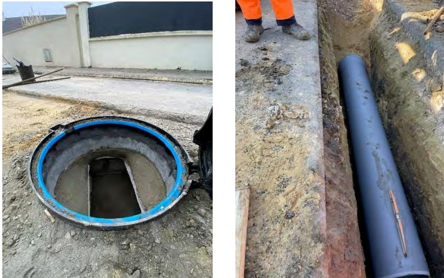
Figure 108 : Extension du réseau **d'eaux pluviales** – Rue Henri Leclerc à Laigneville (DMVA)
