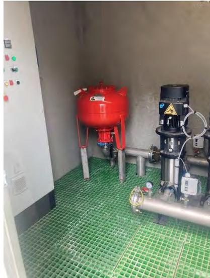
Figure 41 : Renouvellement du ballon anti-bélier – Poste de surpression à Laigneville (VEOLIA)
