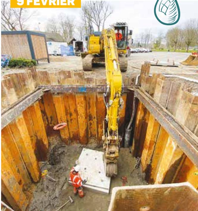
Mise aux normes des installations d'assainissement : sécurisation de la collecte des eaux usées par le redimensionnement d'un poste de refoulement télésurveillé.
