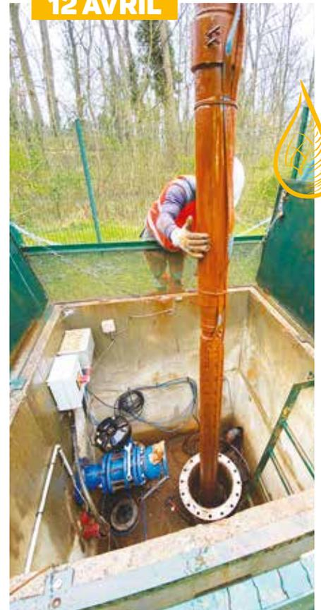
Régulièrement, une inspection télévisuelle des puits qui captent l'eau potable est réalisée afin de vérifier leur fonctionnement. Elle permet d'évaluer le niveau de colmatage des crépines, et d'anticiper différentes interventions d'entretien de l'installation.
