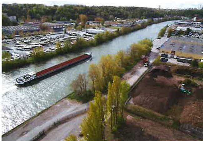
Quai d'amont à Nogent-sur-Oise
