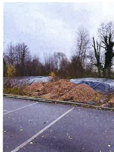
Andains de stockage des terres excavées sur le site Desnoyers
