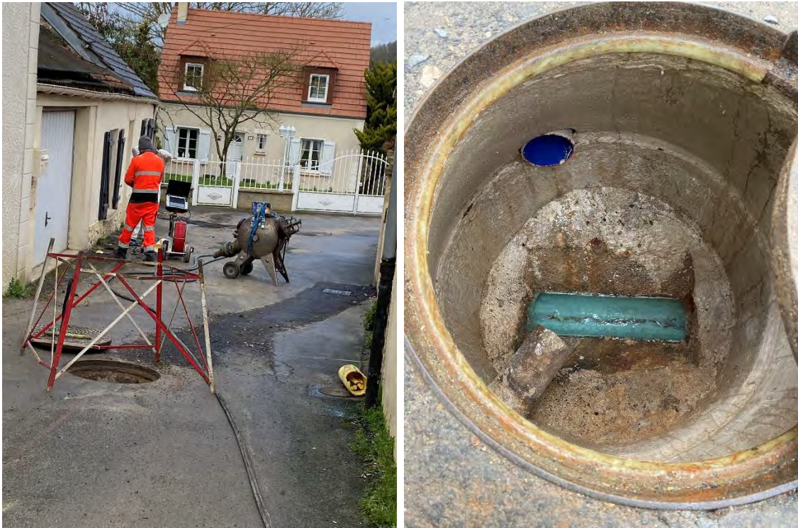
Figure 121 : Chemisage du réseau d'eaux usées – rue de la Chesnaie, rue Fontaine Saint Maur et impasse Courtil Grand-mère à Bailleval (DEGAUCHY - TELEREP)
