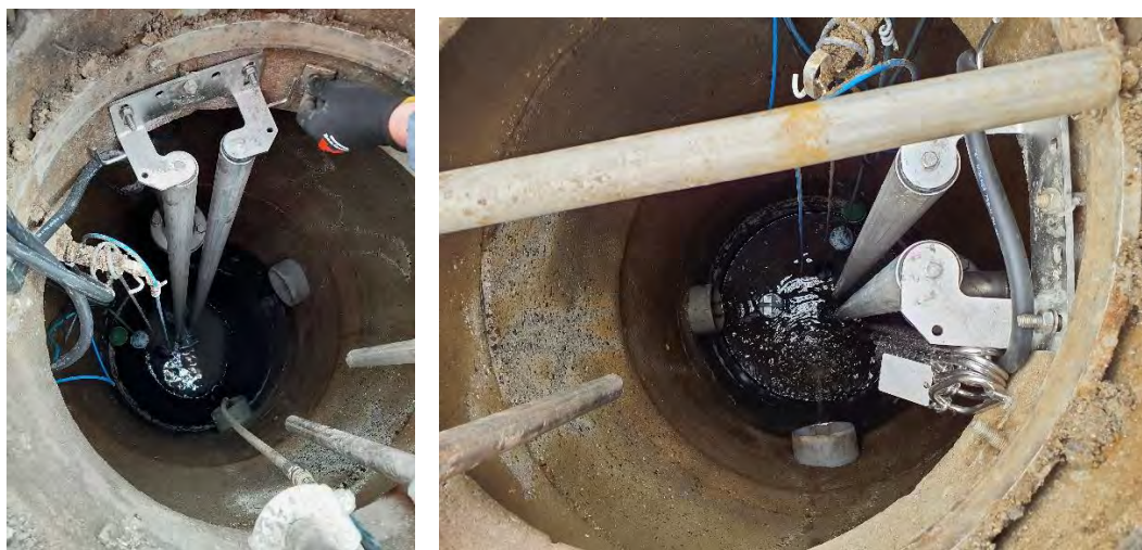
Figure 147 : Renouvellement de la pompe du PR « PYRAMIDE » à Liancourt (VEOLIA)
