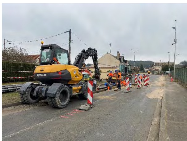
Figure 49 : Renouvellement et extension du réseau d'eau potable – Allée des Frênes à Rantigny (DMVA)
