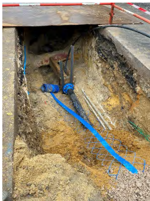
Figure 51 : Extension du réseau d'eau potable – Rue Emile Zola à Rantigny (Régie CCLVD)
