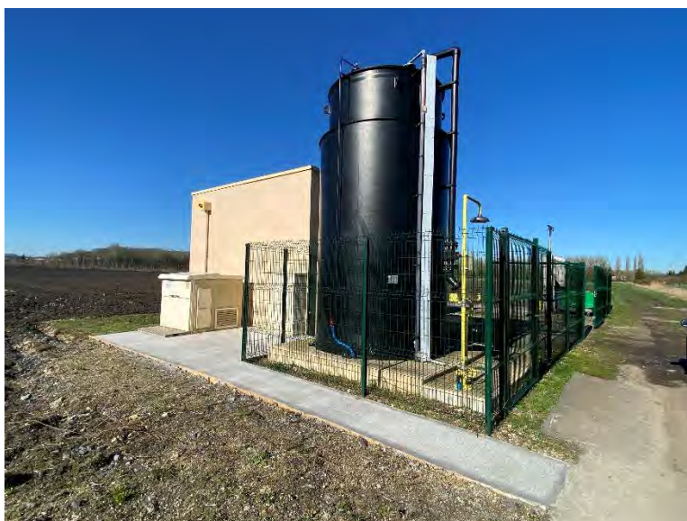
Figure 144 : Réalisation d'une dalle d'accès au transformateur électrique du PR « BEREGOVOY » à Laigneville (DMVA)
