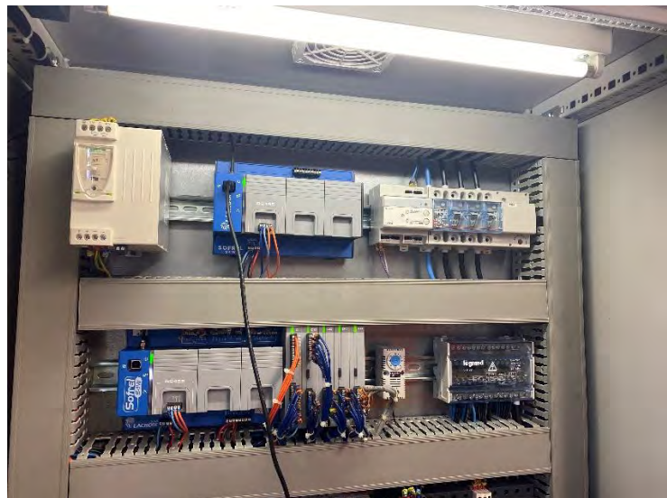
Figure 41 : Installation de 2 sofrel S4W sur le poste de surpression Nogent (VEOLIA)
