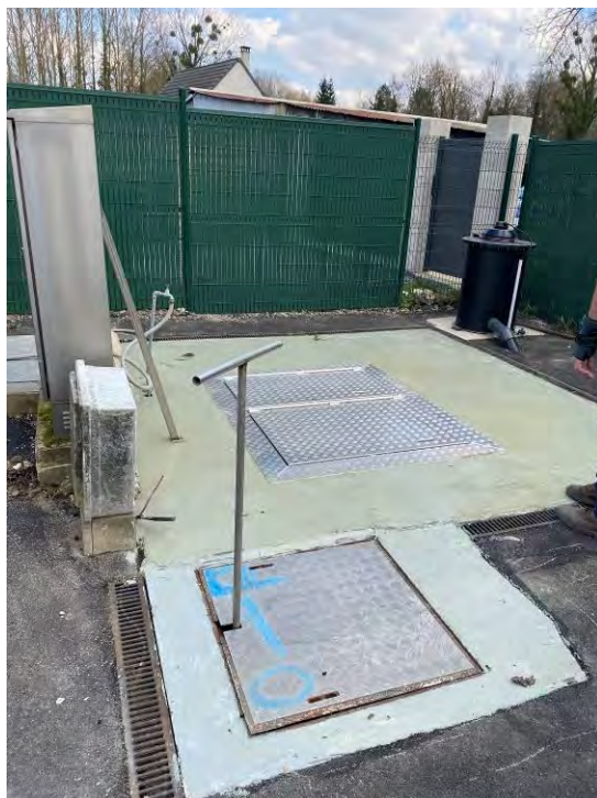
Figure 157 : Désodorisation du PR THEBAULT à Laigneville
