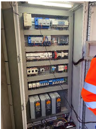
Figure 41 : Installation de 2 sofrel S4W sur le poste de surpression Nogent (VEOLIA)
