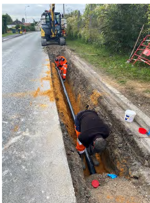
Figure 50 : Renouvellement et extension du réseau d'eau potable – Rue de la Brèche à Rantigny (Régie CCLVD)
