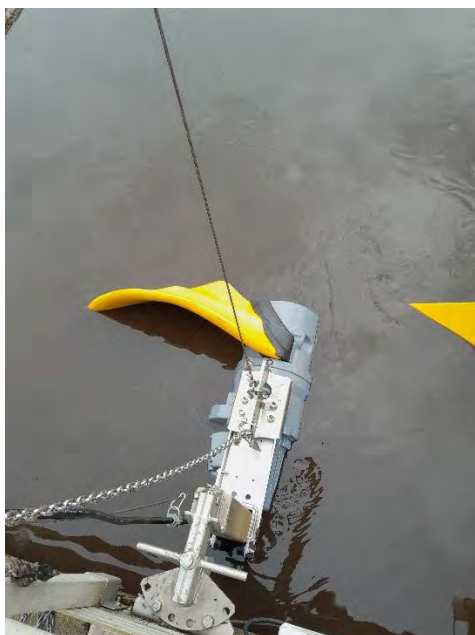
Figure 172 : Renouvellement d'un agitateur pâle banane du bassin d'aération (VEOLIA)
