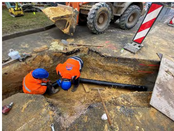
Figure 49 : Renouvellement et extension du réseau d'eau potable – Allée des Frênes à Rantigny (DMVA)
