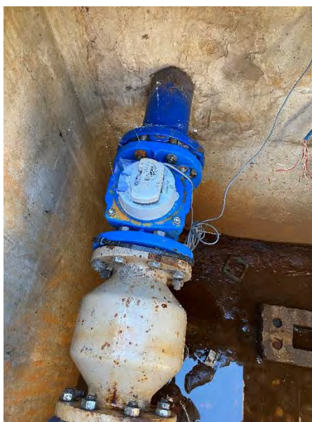
Figure 24 : Renouvellement du compteur du F10 (VEOLIA)
