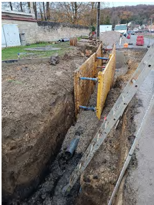
Figure 142 : Travaux d'extension du réseau d'eaux usées – Rue de la République à Monchy Saint Eloi (DMVA)
