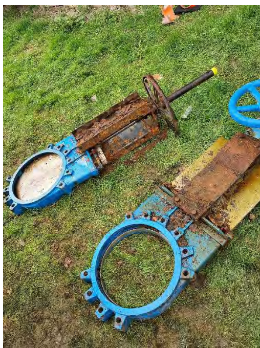
Figure 169 : Renouvellement des vannes de by-pass du poste de relevage (VEOLIA)
