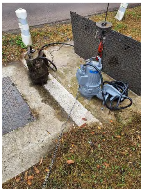
Figure 146 : Renouvellement d'une pompe du PR « SACY » à Labruyère (VEOLIA)
