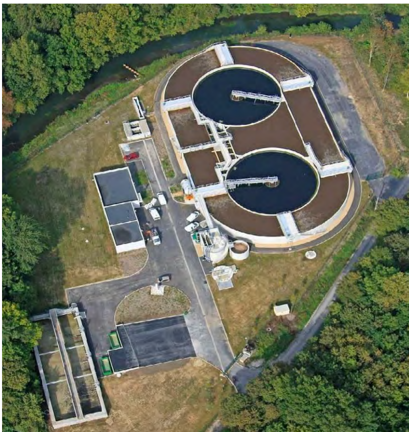
Figure 162 : Vue aérienne de la step de Monchy Saint Eloi
