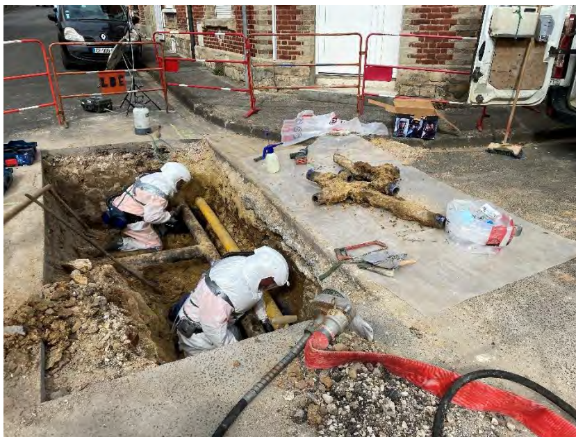
Figure 84 : Mesures d'empoussièrement lors d'une intervention sur conduite en amiante ciment
