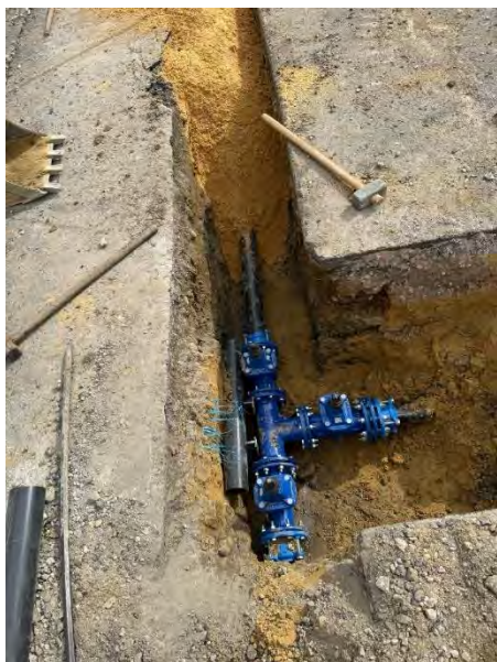
Figure 45 : Renouvellement de la conduite et des branchements d'eau potable – Rue Louis Portebois à Laigneville (Régie CCLVD)
