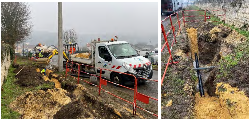
Figure 47 : Renforcement du réseau d' eau potable – Rue de la République à Monchy Saint Eloi (Régie CCLVD)
