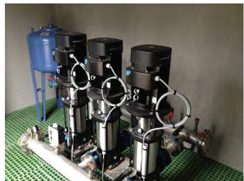
Figure 39 : Poste de surpression Rue de Nogent à Laigneville
