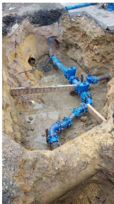
Figure 46 : Renouvellement de la conduite et des branchements d'eau potable – Rue de la Chesnaie, rue Fontaine Saint Maur et impasse Courtil Grand-mère à Bailleval (DEGAUCHY)
