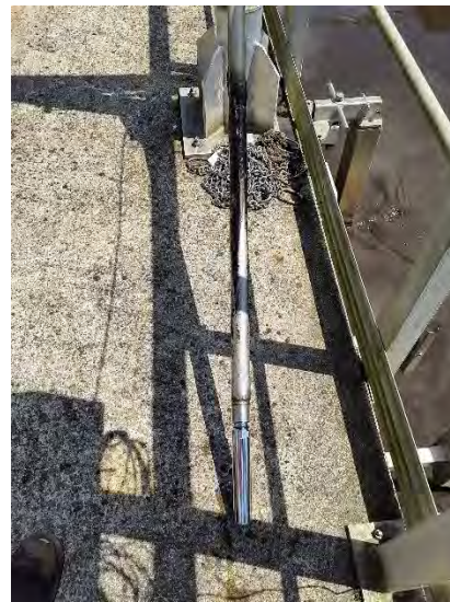
Figure 171 : Renouvellement de sonde (VEOLIA)
