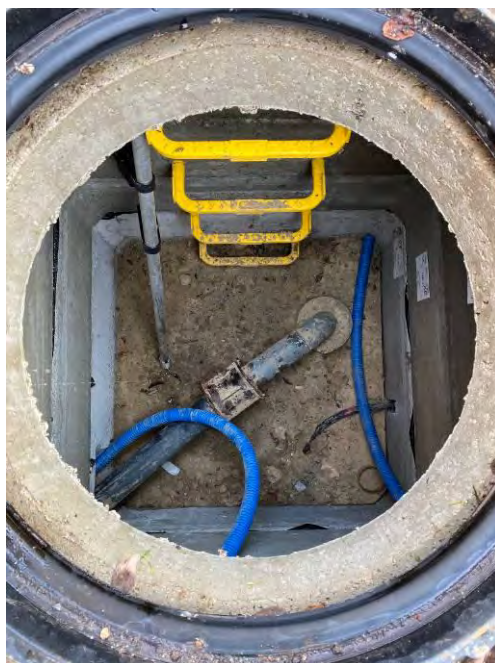
Figure 158 : Traitement anti H_2S du PR MARAIS à Labruyère
