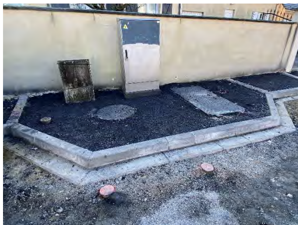
Figure 149 : Renouvellement de la trappe d'accès au PR « VARENNE » à Mogneville (VEOLIA)
