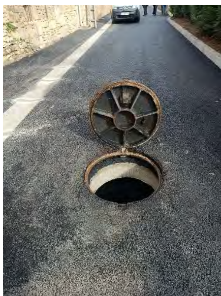
Figure 160 : Création de puits d'infiltration – Allée de la Planchette à Mogneville (DEGAUCHY)
