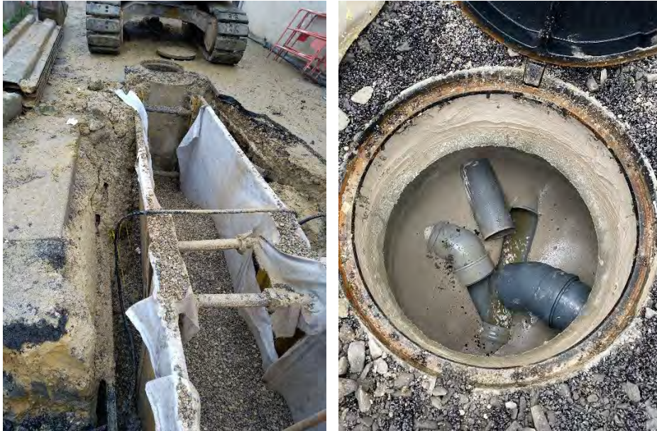
Figure 120 : Renouvellement des réseaux d'eaux usées et d'eaux pluviales – rue de la Chesnaie, rue Fontaine Saint Maur et impasse Courtil Grand-mère à Bailleval (DEGAUCHY)
