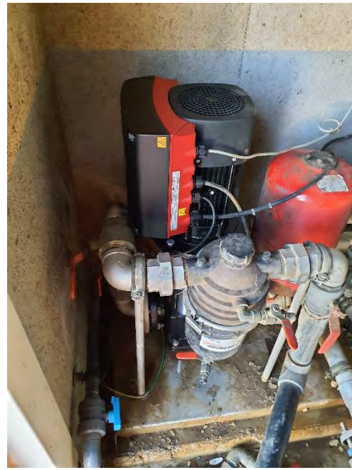
Figure 170 : Renouvellement du skid d'eau industrielle (VEOLIA)
