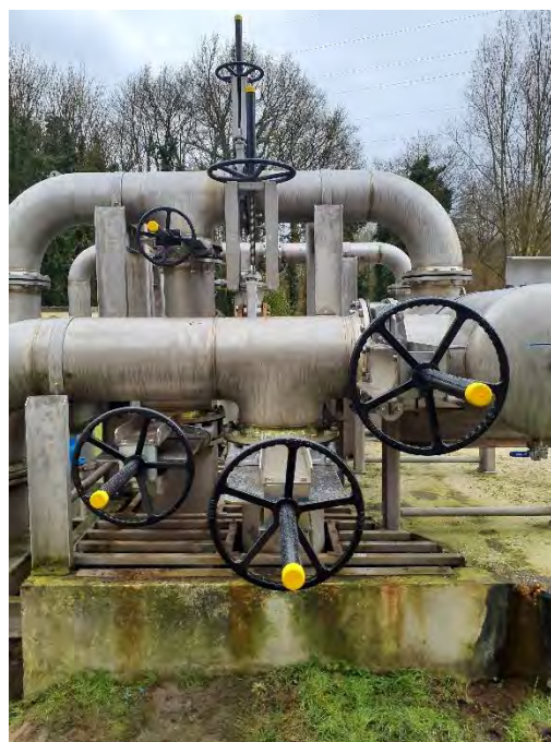
Figure 169 : Renouvellement des vannes de by-pass du poste de relevage (VEOLIA)
