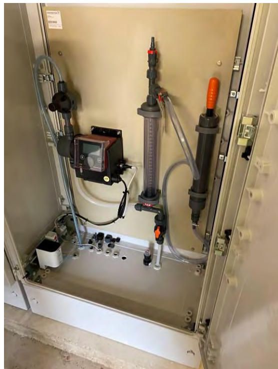
Figure 156 : Traitement anti H 2 S du PR BEREGOVVOY à Liancourt
