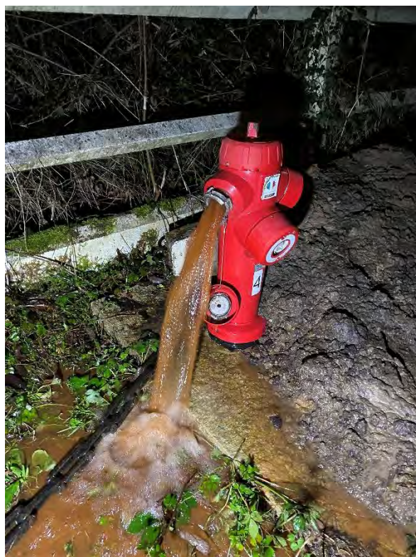
Figure 15 : Purge du réseau après la réparation d'une fuite sur réseau
