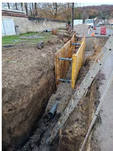
Figure 127 : Extension du réseau d'eaux usées – Rue de la République à Monchy Saint Eloi (DMVA)
