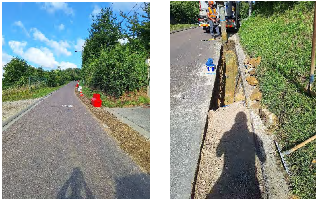
Figure 48 : Extension de la conduite d'eau potable – Rue de la source à Labruyère (Régie CCLVD)
