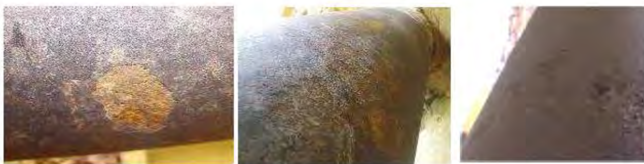
Figure 57 : Canalisation du chemin Berenger à Labruyère
