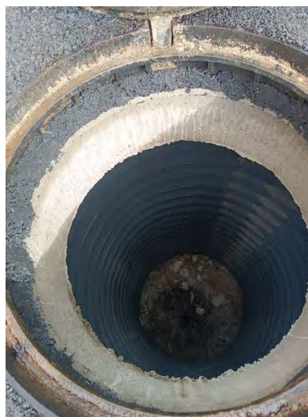
Figure 160 : Création de puits d'infiltration – Allée de la Planchette à Mogneville (DEGAUCHY)
