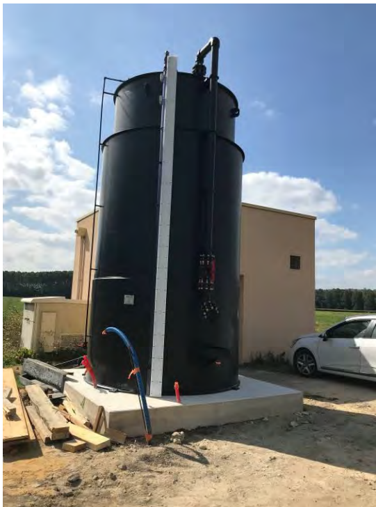
Figure 156 : Traitement anti H 2 S du PR BEREGOVVOY à Liancourt
