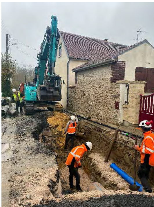
Figure 46 : Renouvellement de la conduite et des branchements d'eau potable – Rue de la Chesnaie, rue Fontaine Saint Maur et impasse Courtil Grand-mère à Bailleval (DEGAUCHY)
