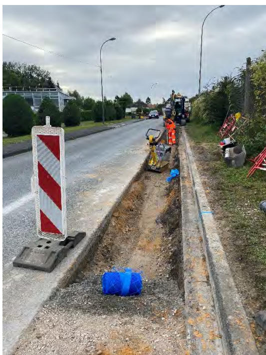
Figure 50 : Renouvellement et extension du réseau d'eau potable – Rue de la Brèche à Rantigny (Régie CCLVD)
