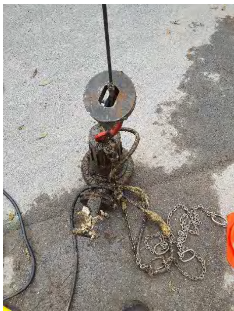
Figure 145 : Renouvellement d'une pompe du PR « MOULIN » à Cauffry (VEOLIA)
