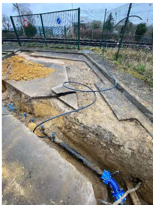
Figure 51 : Extension du réseau d'eau potable – Rue Emile Zola à Rantigny (Régie CCLVD)
