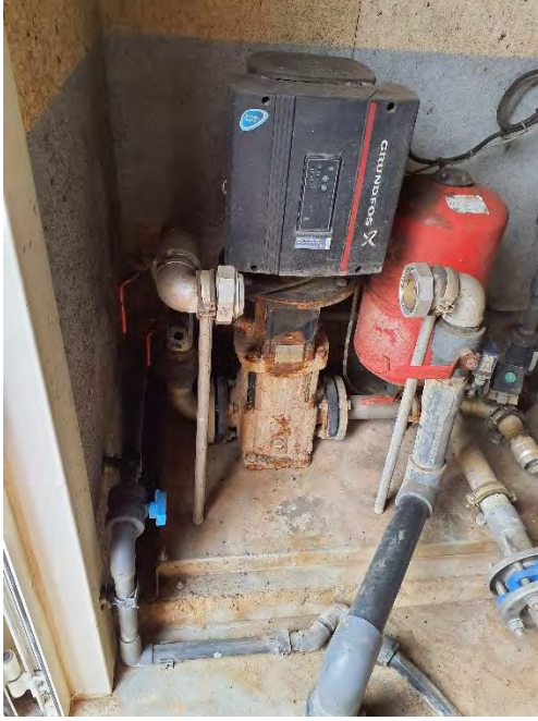
Figure 170 : Renouvellement du skid d'eau industrielle (VEOLIA)
