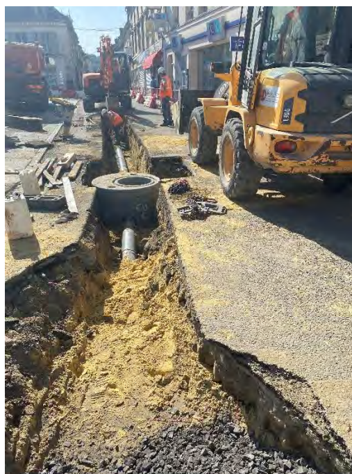
Figure 122 : Travaux de mise en séparatif – Rue Victor Hugo à Liancourt (DEGAUCHY)
