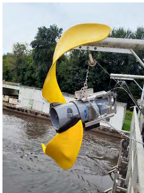
Figure 172 : Renouvellement d'un agitateur pâle banane du bassin d'aération (VEOLIA)
