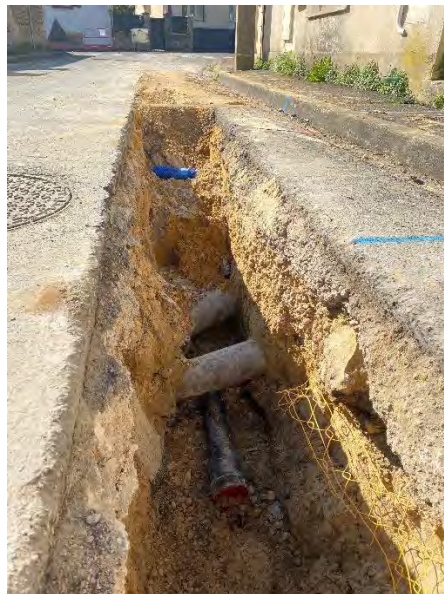
Figure 45 : Renouvellement de la conduite et des branchements d'eau potable – Rue Louis Portebois à Laigneville (Régie CCLVD)
