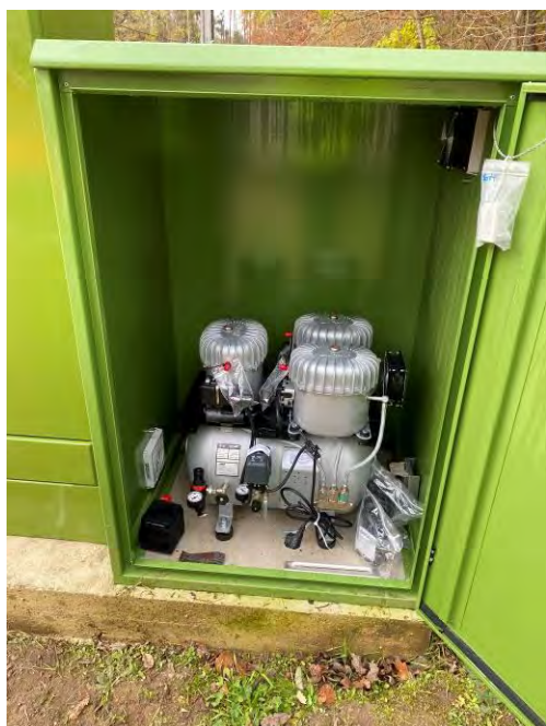
Figure 158 : Traitement anti H_2S du PR MARAIS à Labruyère
