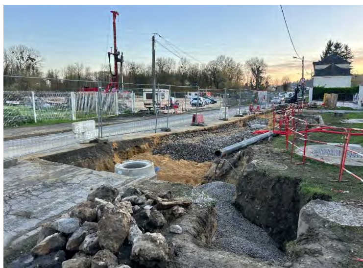
Figure 127 : Extension du réseau d'eaux usées – Rue de la République à Monchy Saint Eloi (DMVA)
