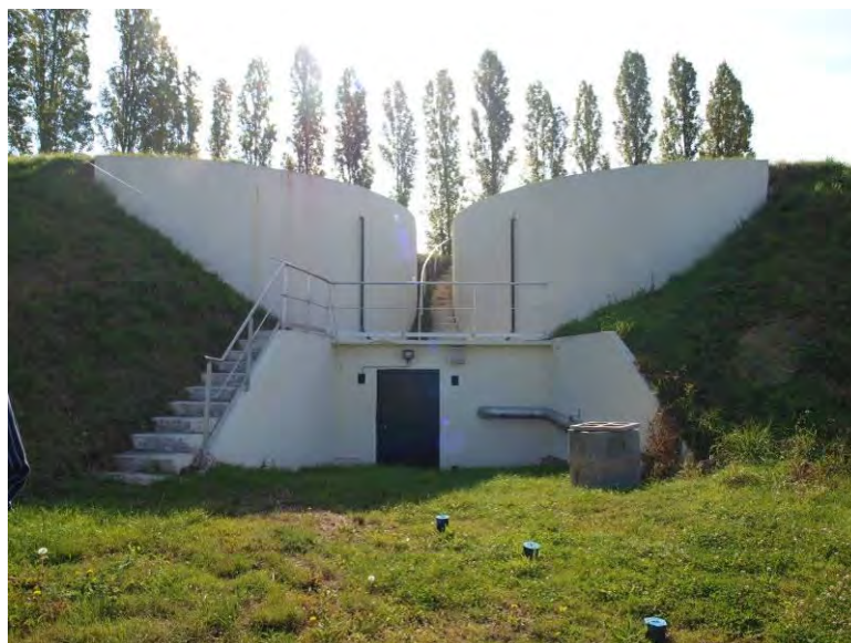
Figure 36 : Réservoirs semi-enterrés de Liancourt (2 x 750 m 3 )
