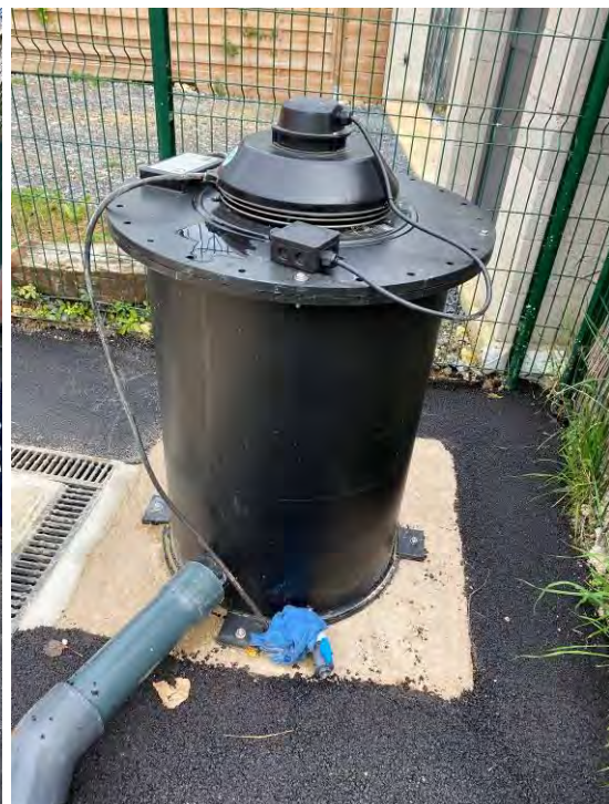
Figure 157 : Désodorisation du PR THEBAULT à Laigneville
