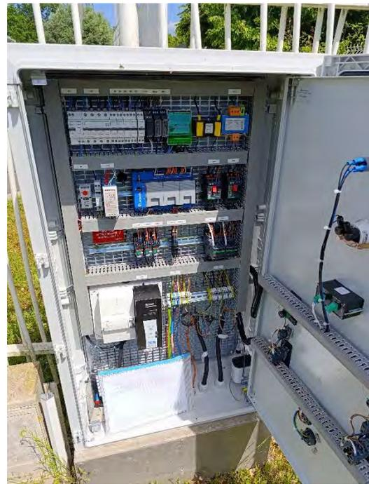
Figure 149 : Renouvellement **de l'armoire électrique du PR « NOGENT »** à Laigneville (VEOLIA)
