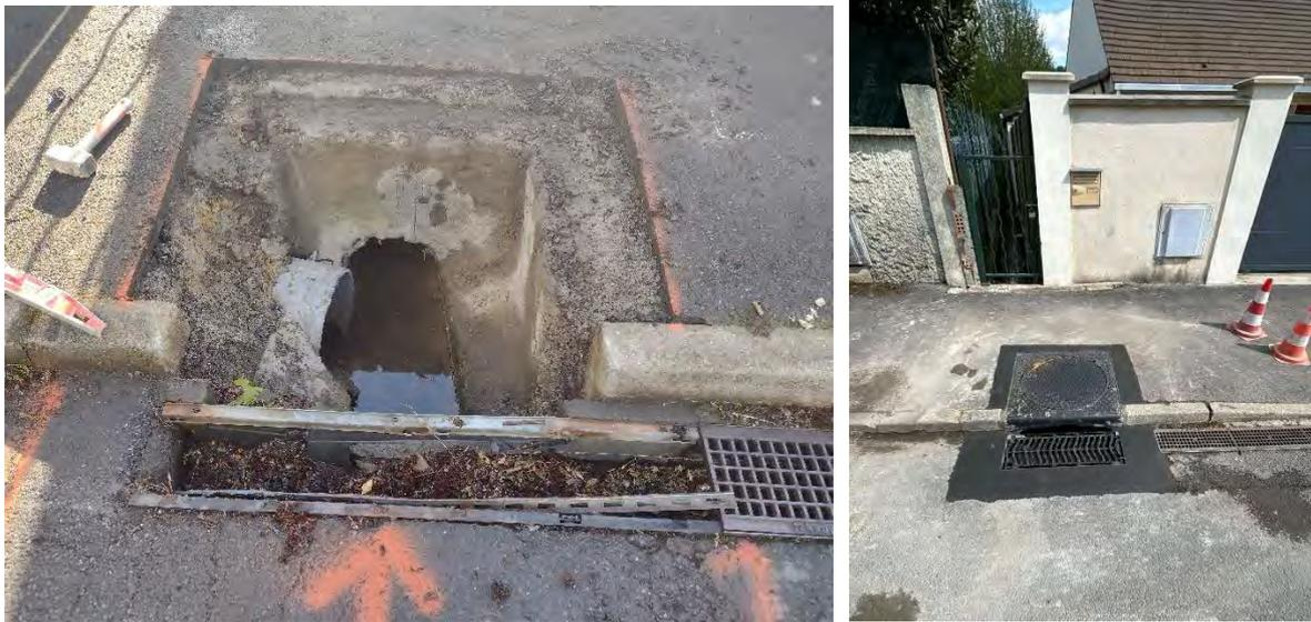
Figure 129 : Réparation d'un avaloir – Rue de la liberté à Laigneville (DMVA)
