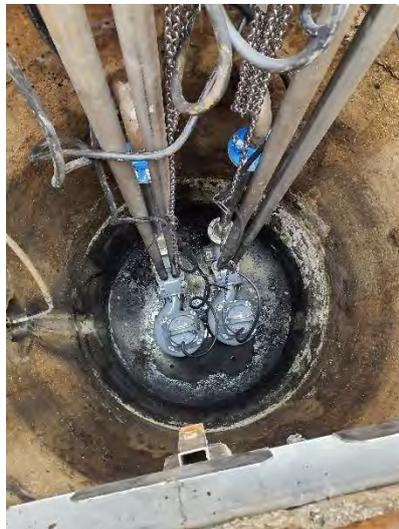
Figure 153 : Renouvellement des 2 pompes sur le PR « VARENNE » à Mogneville (VEOLIA)
