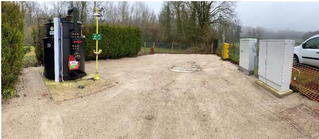
Figure 168 : Traitement anti H<sub>2</sub>S du PR PONCEAU à Verderonne
