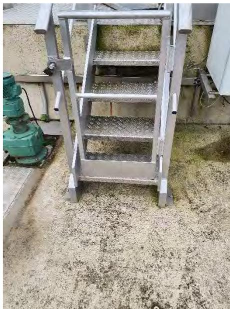
Figure 183 : **Portillon d'accès aux canaux de dégrillage (VEOLIA)**
