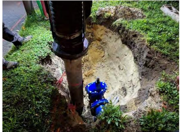
Figure 47 : Renouvellement de la conduite d'eau potable – Rond-point Comasco à Liancourt (DEGAUCHY)
