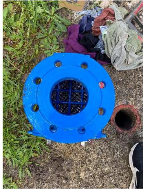
Figure 24 : Renouvellement du filtre avant compteur du F10 (fourniture VEOLIA, pose REGIE)
