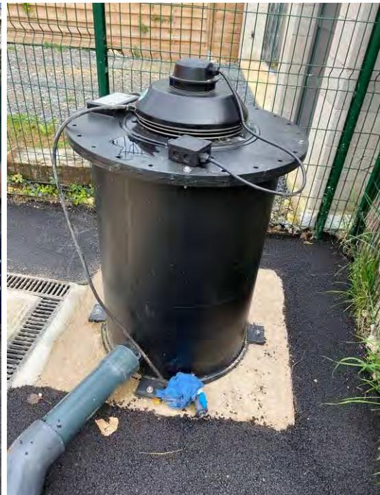
Figure 166 : Désodorisation du PR THEBAULT à Laigneville
