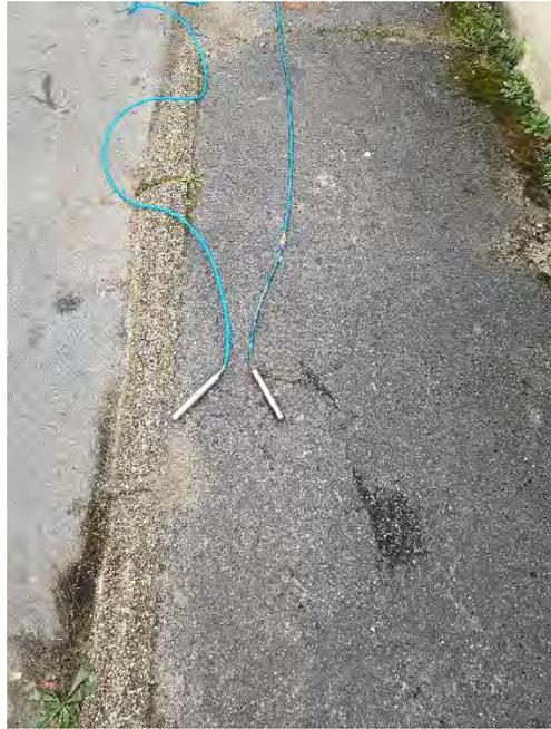
Figure 154 : Renouvellement de la sonde de niveau du PR « VARENNE » à Mogneville (VEOLIA)
