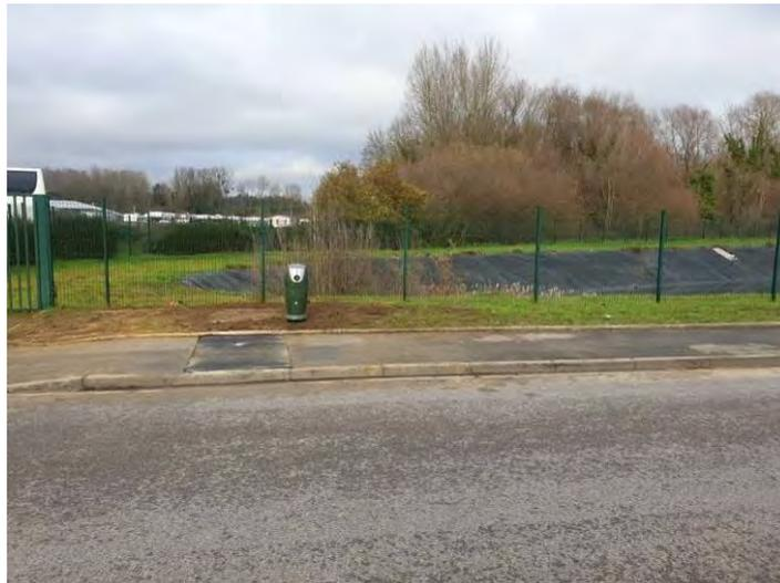
Figure 73 : Borne de puisage – Rue Joseph Cugnot à Laigneville
