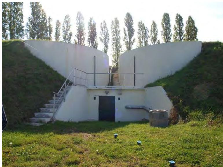
Figure 37 : Réservoirs semi-enterrés de Liancourt (2 x 750 m<sup>3</sup>)
