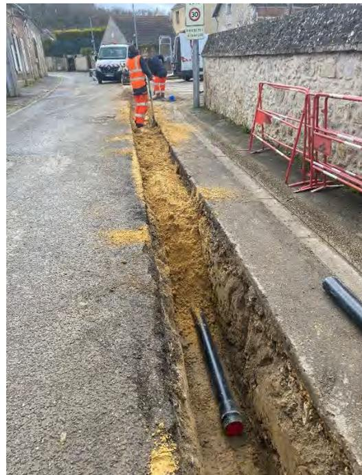
Figure 48 : Renouvellement de la conduite et des branchements d'eau potable – Grande rue à Cauffry (Régie CCLVD)
