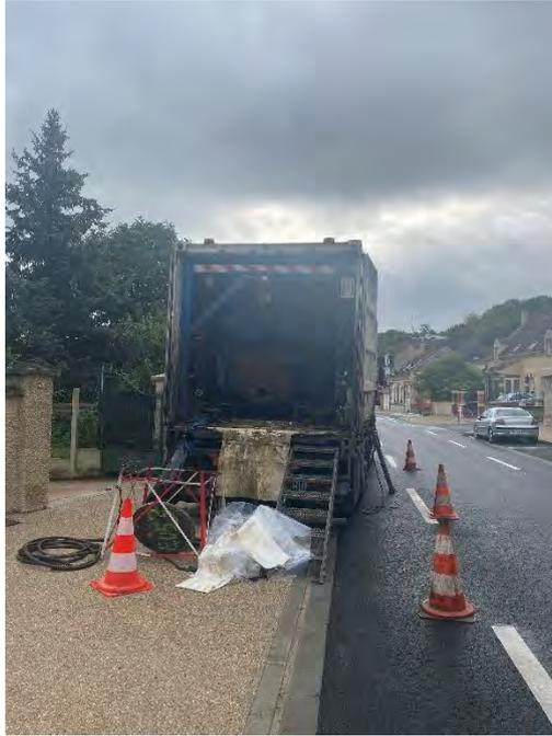
Figure 118 : **Chemisage des réseaux d'assainissement** – Rue de la République à Laigneville
