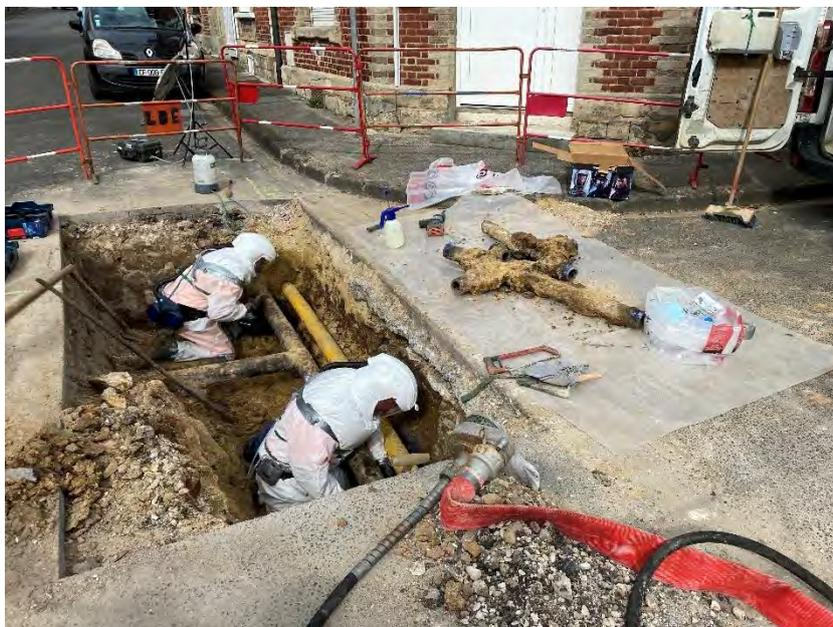
Figure 81 : **Mesures d'empoussièrement lors d'une intervention sur conduite en amiante ciment**
