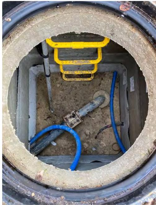
Figure 167 : Traitement anti H<sub>2</sub>S du PR MARAIS à Labruyère
