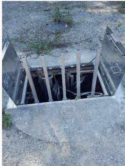
Figure 157 : Renouvellement **de la trappe d'accès au** PR « PONCEAU » à Verderonne (VEOLIA)
