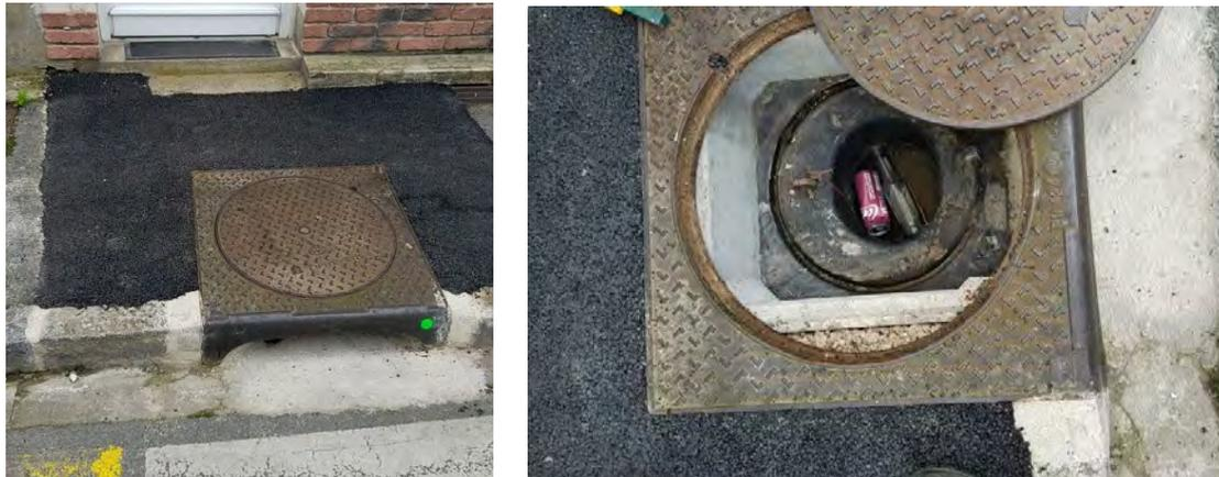
Figure 132 : Clapet anti-odeur sur avaloir – Rue Pasteur à Liancourt (DMVA)
