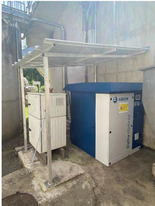
Figure 189 : Renouvellement du surpresseur d'air du biomaster (traitement des graisses) et création **d'une réhausse et couverture pour le préleveur (VEOLIA)**
