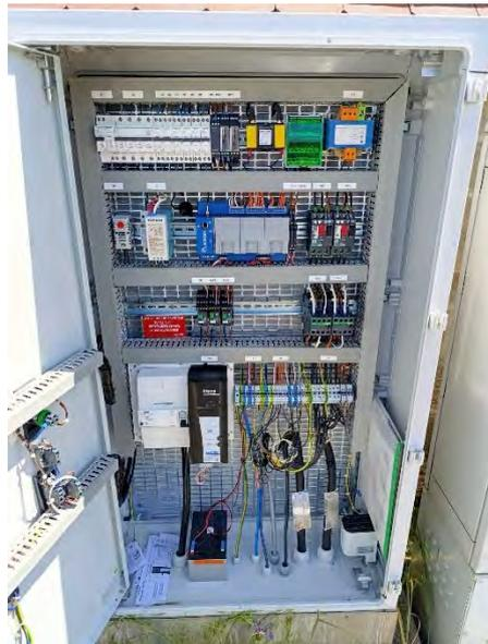
Figure 151 : Renouvellement **de l'armoire électrique du PR « ISORE »** à Bailleval (VEOLIA)
