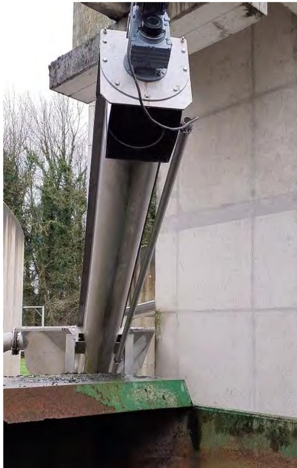
Figure 187 : Réparation auge et vis du classificateur (VEOLIA)
