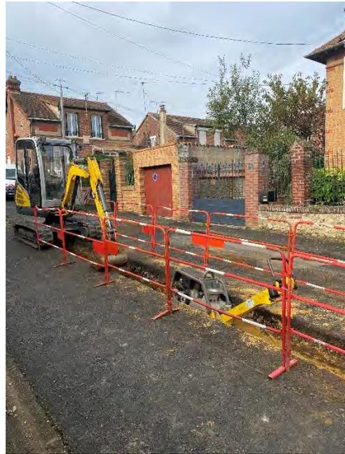
Figure 46 : Renouvellement de la conduite et des branchements **d'eau potable** – Rue Dubuy Raguet à Rantigny (Régie CCLVD)
