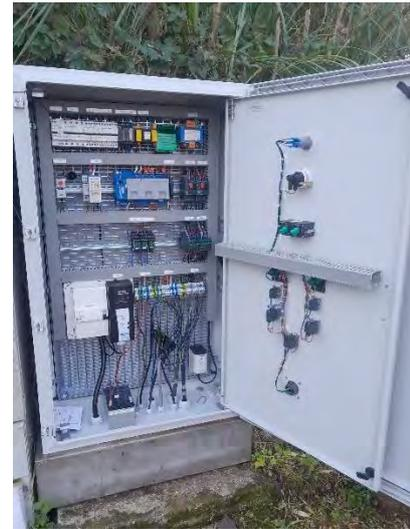
Figure 148 : Renouvellement **de l'armoire électrique du PR « MOULIN »** à Bailleval (VEOLIA)
