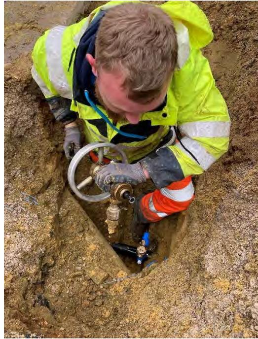
Figure 45 : Renouvellement **de la conduite et des branchements d'eau potable et création d'un maillage** – Rue Carette à Cauffry (Régie CCLVD)
