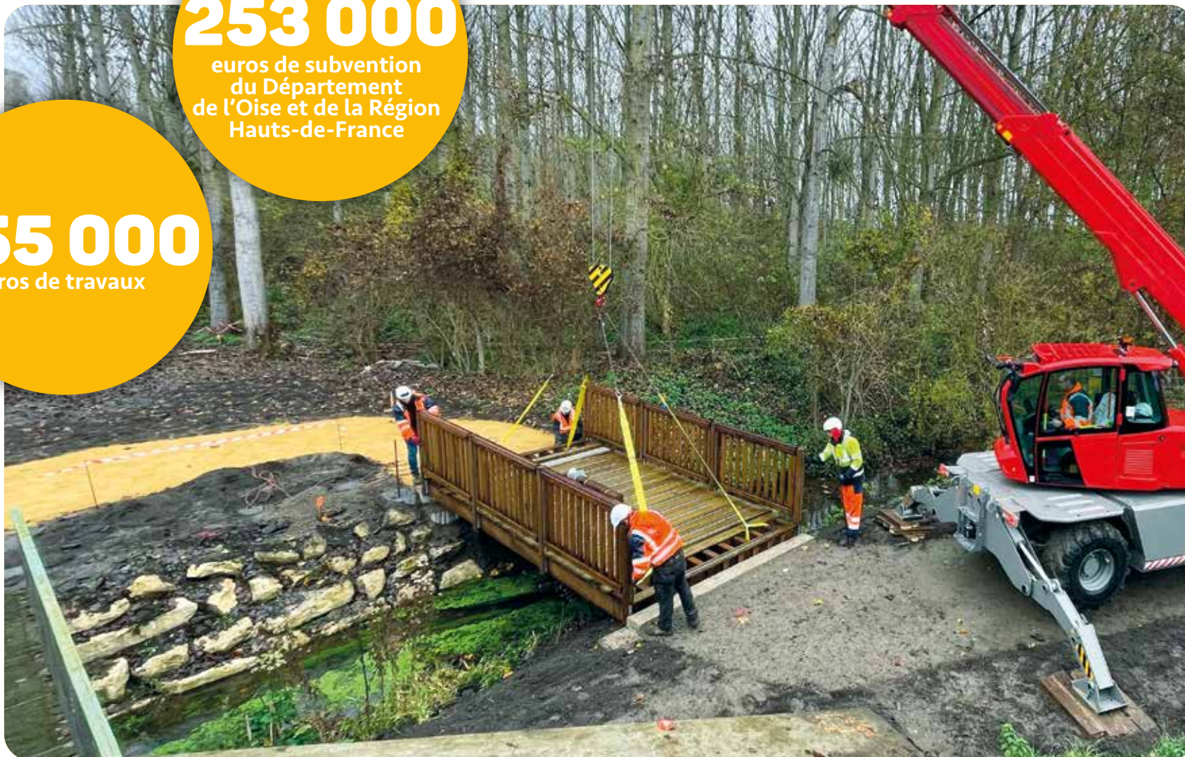
Pose de la passerelle de la voie douce piscine de la Vallée dorée / Parc Chédeville
