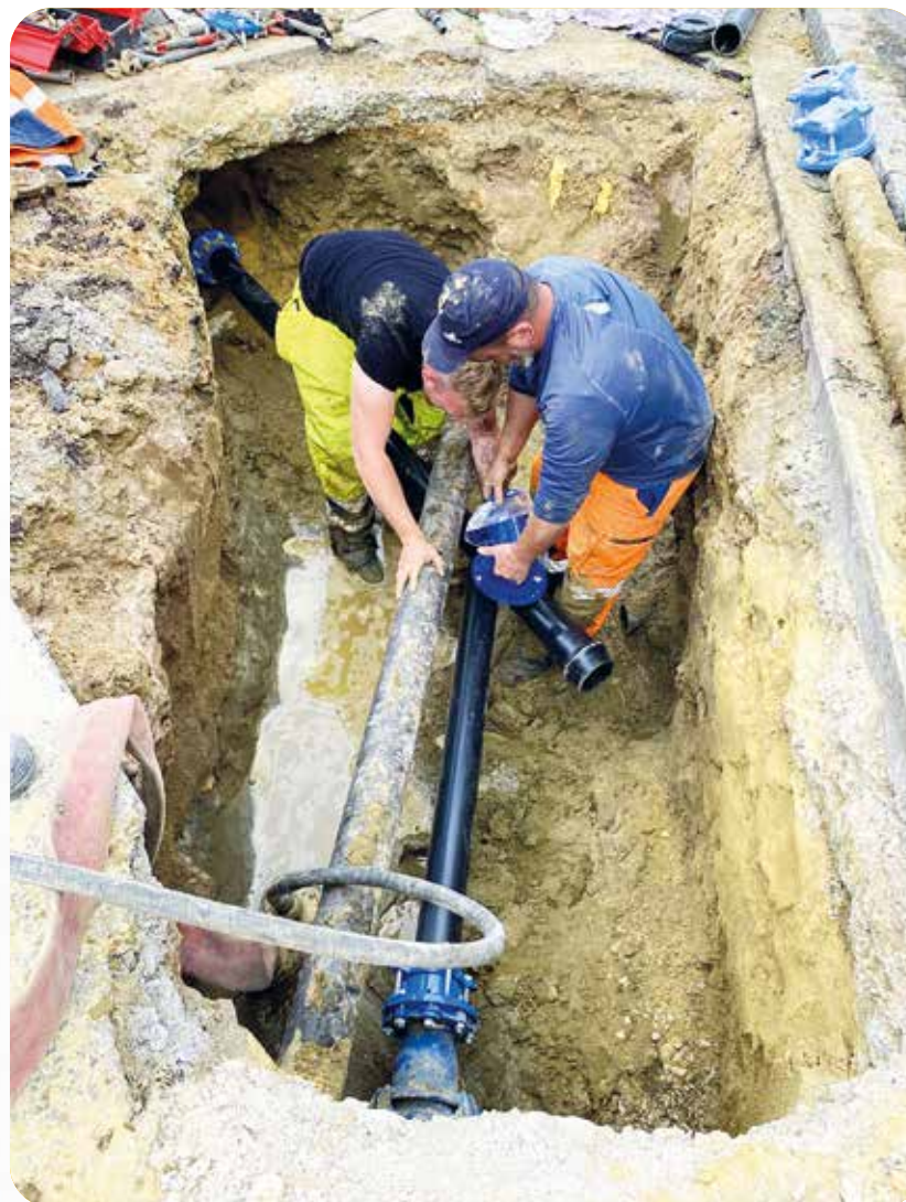
Un renouvellement de la conduite d'eau potable réalisé à Liancourt.
