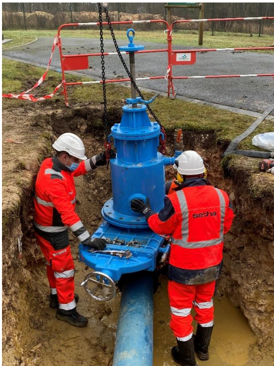
Figure 54 : Création d'un by-pass du réservoir 1500 m 3 (Régie CCLVD / SETHA)
