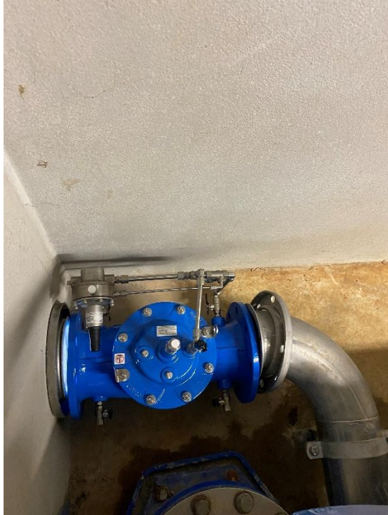
Figure 36 : Vanne de décharge en entrée d'usine (VEOLIA)
