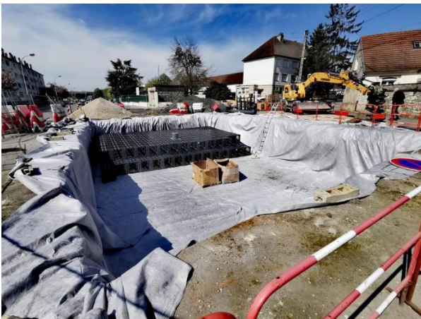
Figure 114 : Casiers d'infiltration des eaux pluviales– Place Chanoine Snejdareck à Liancourt (DEGAUCHY)
