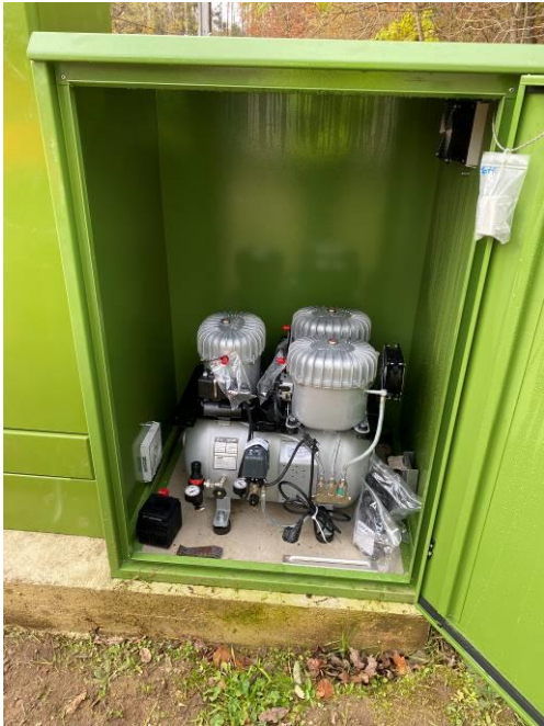
Figure 146 : Traitement anti H 2 S du PR MARAIS à Labruyère
