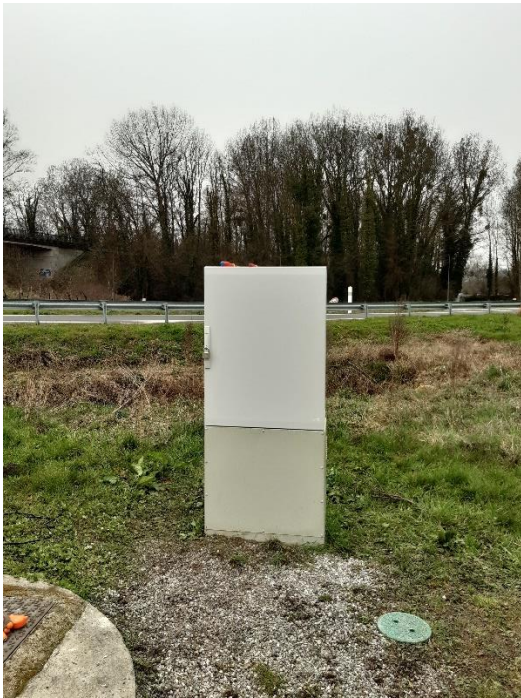
Figure 135 : Renouvellement de l'enveloppe de l'armoire électrique sur le PR « AAGV » à Laigneville (VEOLIA)
