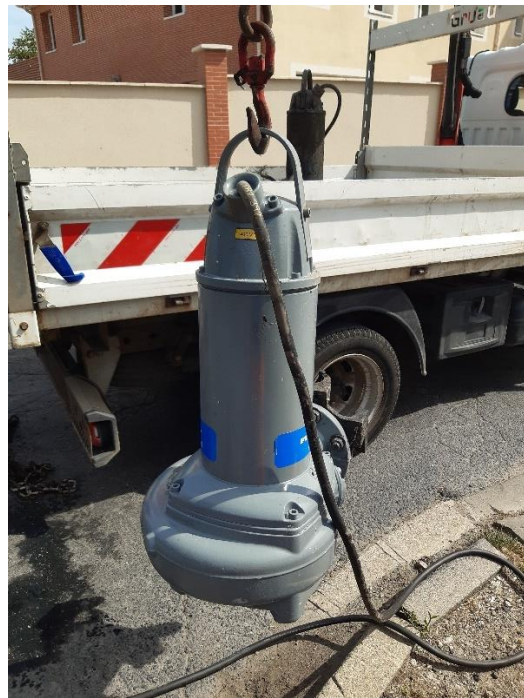
Figure 134 : Renouvellement d'une pompe sur le PR « CURIE » à Laigneville (VEOLIA)
