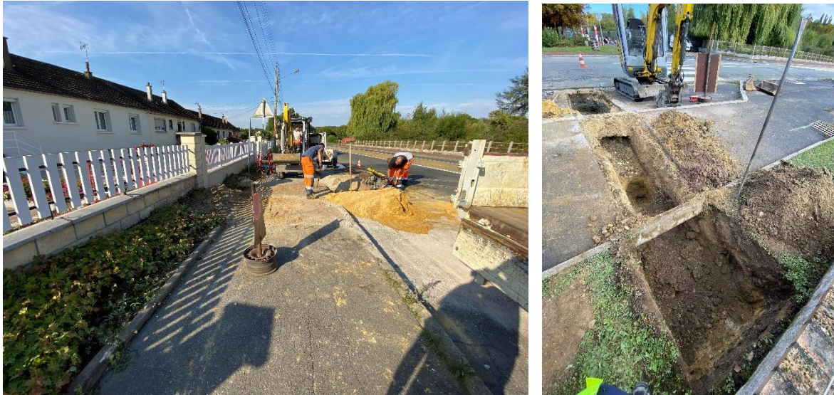
Figure 52 : Mise en conformité de plusieurs branchements complexes – Rue Victor Hugo à Liancourt (Régie CCLVD)
