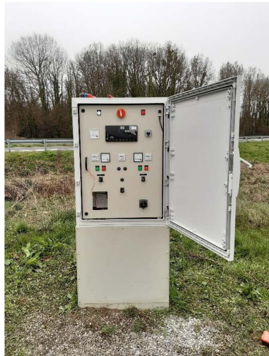
Figure 135 : Renouvellement de l'enveloppe de l'armoire électrique sur le PR « AAGV » à Laigneville (VEOLIA)
