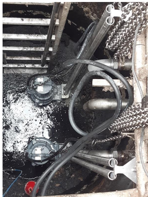
Figure 136 : Renouvellement des pompes sur le PR « LAVOIR » à Liancourt (VEOLIA)
