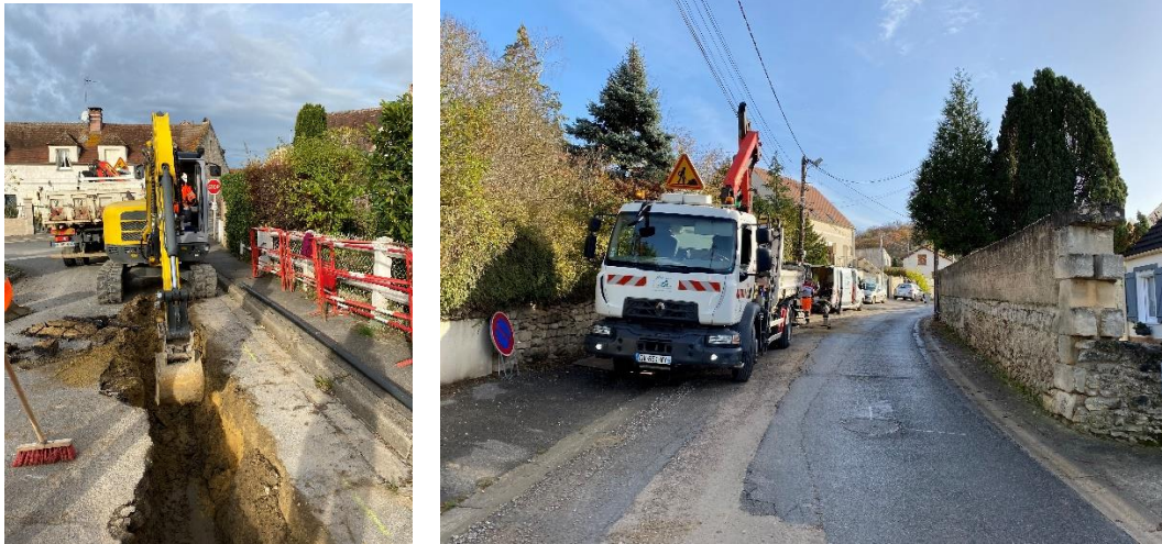
Figure 49 : Renouvellement du réseau – Rue Jean Moulin à Mogneville (Régie CCLVD)
