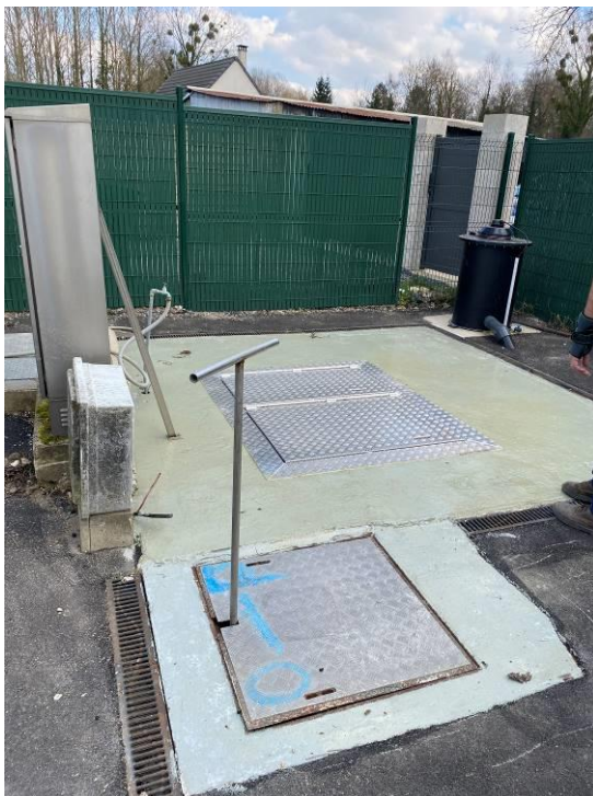
Figure 145 : Désodorisation du PR THEBAULT à Laigneville
