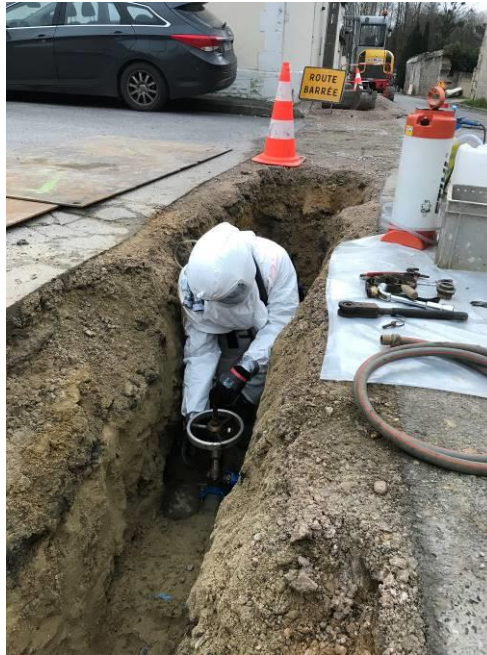
Figure 81 : Intervention sur amiante
