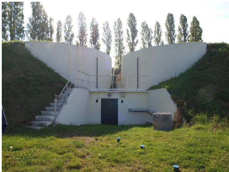
Figure 38 : Réservoirs semi-enterrés de Liancourt (2 x 750 m 3 )
