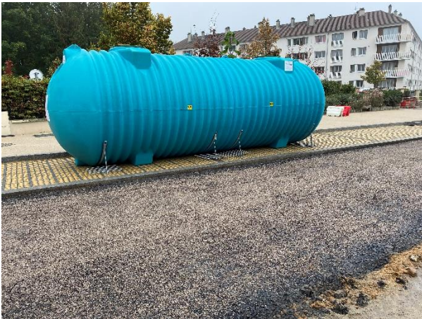
Figure 115 : Récupérateur d'eaux pluviales – Place Chanoine Snejdareck à Liancourt (DEGAUCHY)
