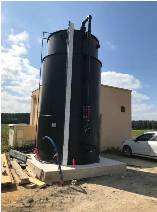
Figure 144 : Traitement anti H 2 S du PR BEREGOVY à Liancourt
