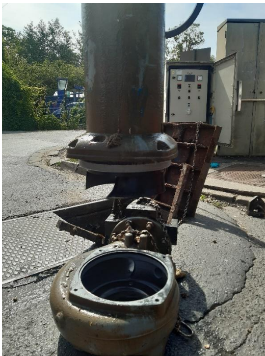
Figure 134 : Renouvellement d'une pompe sur le PR « CURIE » à Laigneville (VEOLIA)
