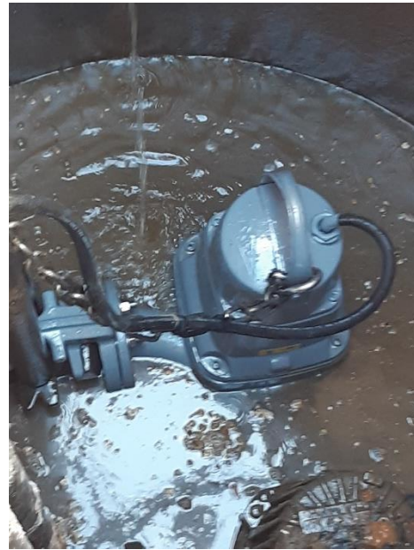
Figure 137 : Renouvellement d'une pompe sur le PR « MARAIS » à Labruyère (VEOLIA)
