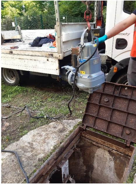
Figure 137 : Renouvellement d'une pompe sur le PR « MARAIS » à Labruyère (VEOLIA)
