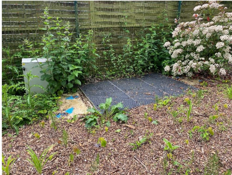
Figure 80 : S3 – Rue du Moulin à Bailleval
