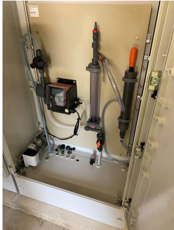
Figure 144 : Traitement anti H 2 S du PR BEREGOVY à Liancourt
