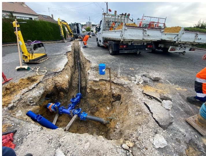
Figure 51 : Renouvellement du réseau – Rue des quinconces à Liancourt (Régie CCLVD)
