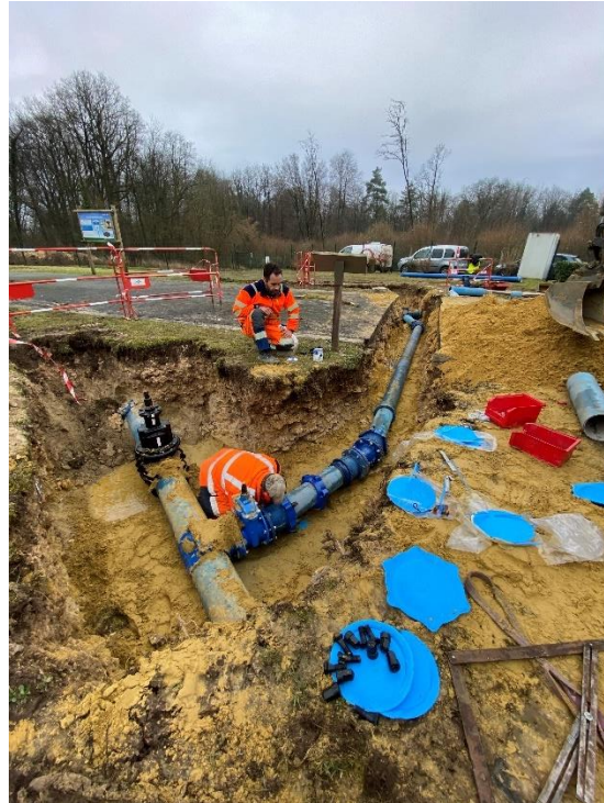
Figure 54 : Création d'un by-pass du réservoir 1500 m 3 (Régie CCLVD / SETHA)
