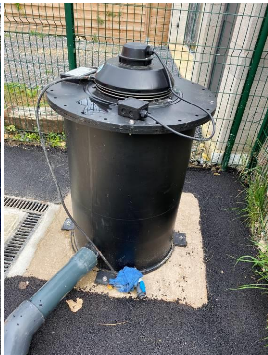
Figure 145 : Désodorisation du PR THEBAULT à Laigneville
