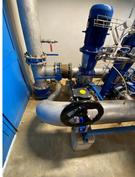
Figure 36 : Vanne de décharge en entrée d'usine (VEOLIA)
