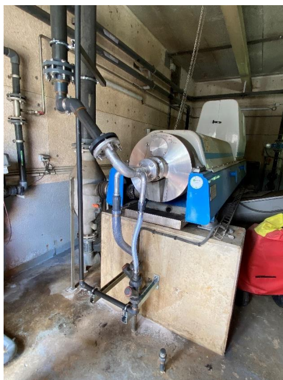
Figure 162 : Canalisations d'alimentation des centrifugeuses (VEOLIA)
