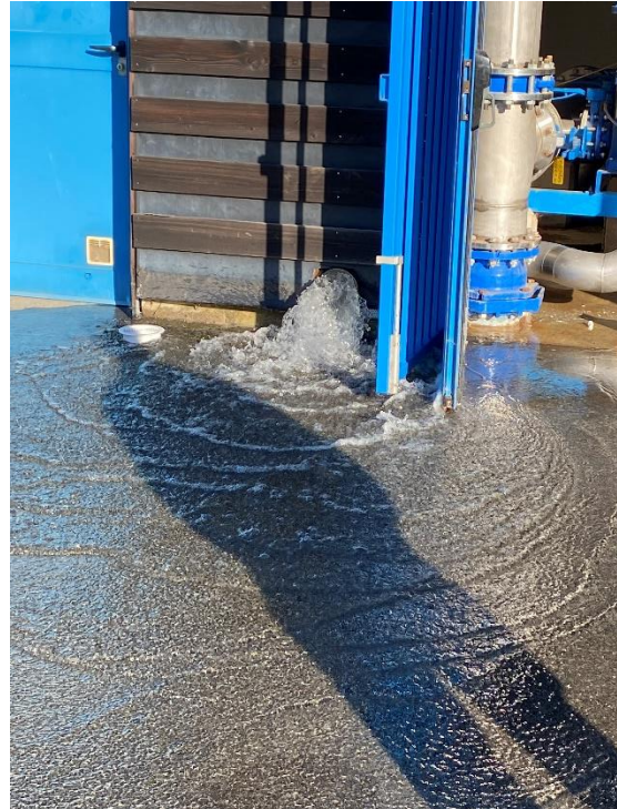
Figure 37 : Test de mise en service de la vanne de décharge
