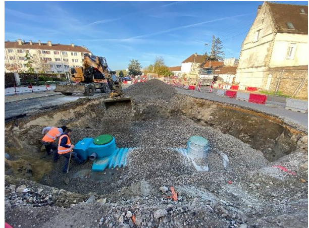
Figure 115 : Récupérateur d'eaux pluviales – Place Chanoine Snejdareck à Liancourt (DEGAUCHY)
