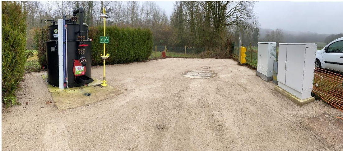
Figure 147 : Traitement anti H 2 S du PR PONCEAU à Verderonne
