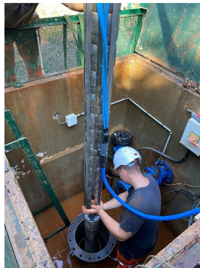
Figure 22 : Renouvellement de la pompe du F10 (VEOLIA)
