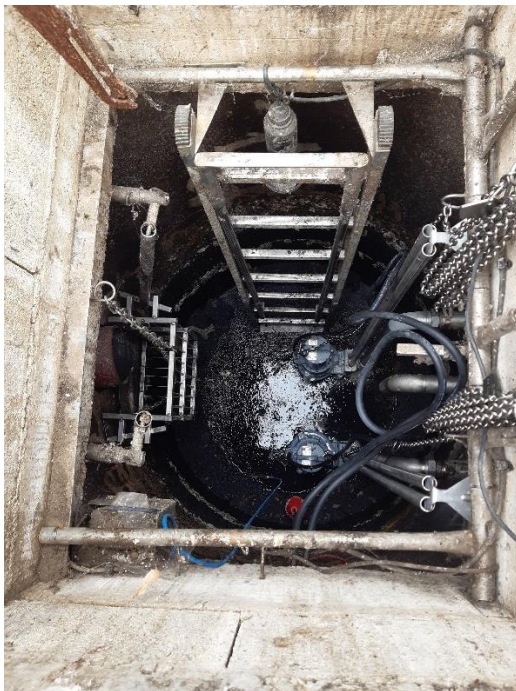
Figure 136 : Renouvellement des pompes sur le PR « LAVOIR » à Liancourt (VEOLIA)
