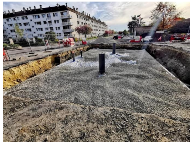
Figure 114 : Casiers d'infiltration des eaux pluviales– Place Chanoine Snejdareck à Liancourt (DEGAUCHY)
