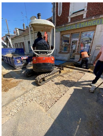
Figure 118 : Reprise ponctuelle de branchements d'eaux usées – Avenue de la gare à Rantigny (DMVA)
