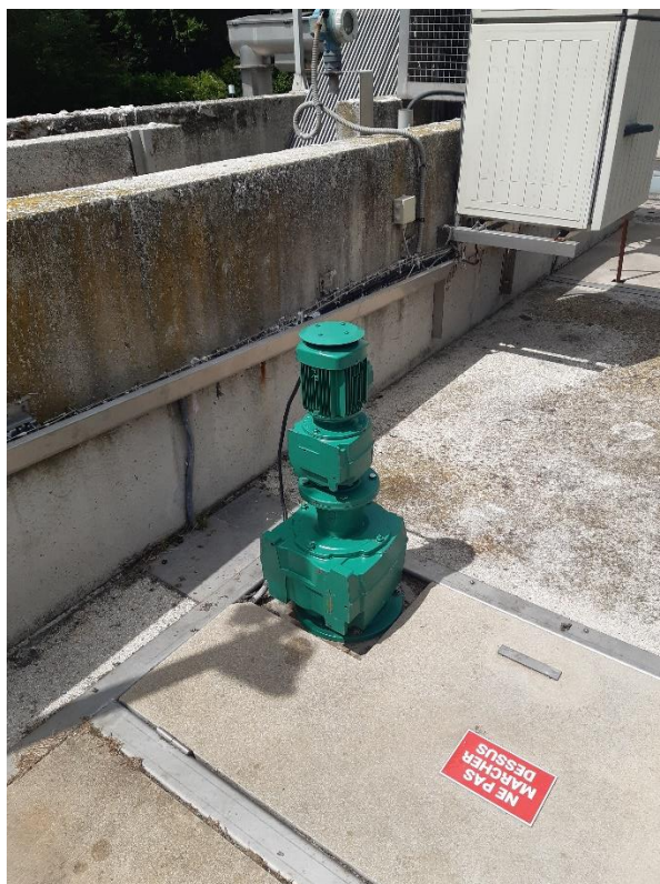
Figure 161 : Motoréducteur à graisses (VEOLIA)
