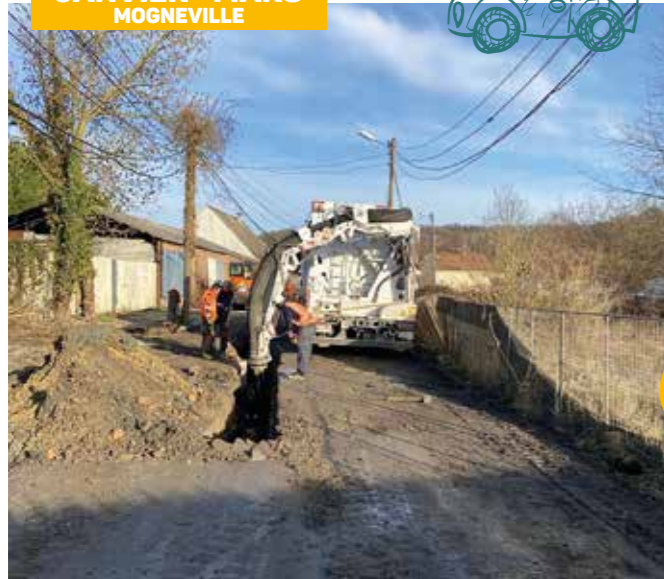
Rue du Saint Sacrement - Des travaux de renouvellement pour améliorer la distribution de l'eau potable.
