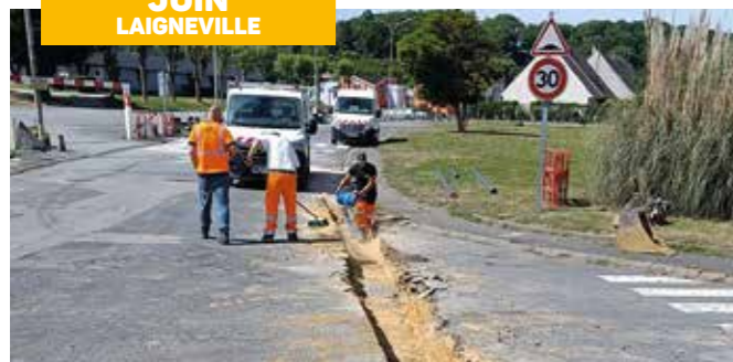
Rue des Cerisiers - Mise en conformité des branchements et du réseau d'eau potable.
