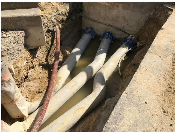
**Figure 150 : Gibeaux sur les canalisations du poste de relèvement (SUEZ)**
