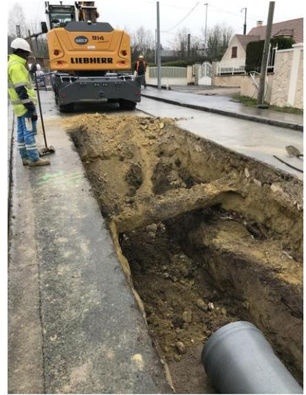
**Figure 113 : Travaux de renouvellement du réseau d'eaux usées et d'eaux pluviales – Rue Parmentier à Rantigny (SADE)**
