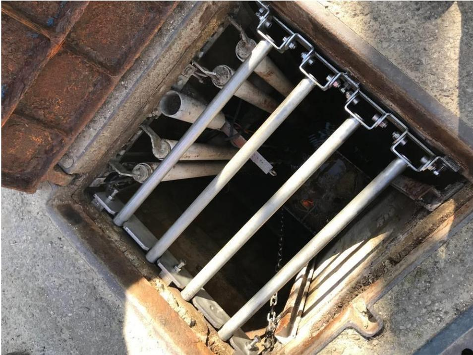
**Figure 129 : Installation de barreaux anti-chutes sur le PR Boues à Bailleval**
