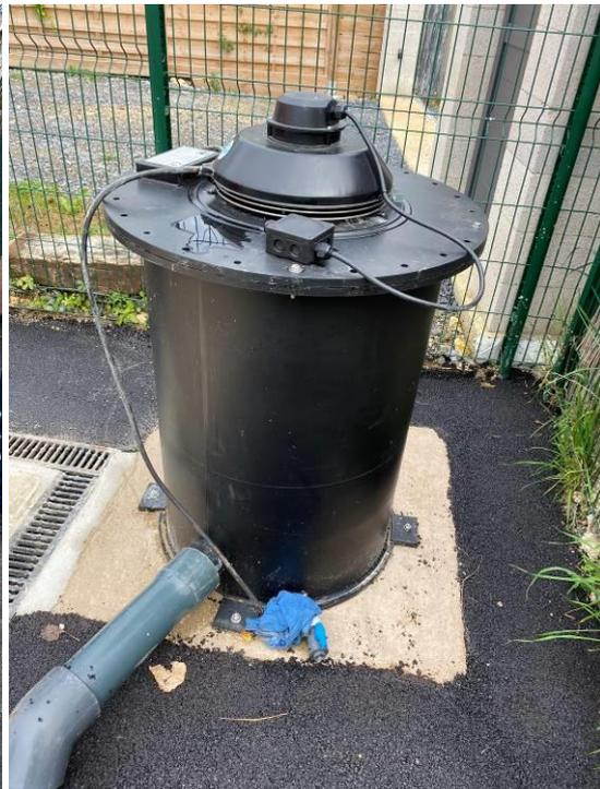
**Figure 137 : Désodorisation du PR THEBAULT à Laigneville**
