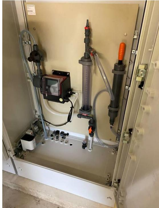
**Figure 136 : Traitement anti H<sub>2</sub>S du PR BEREGOVY à Liancourt**
