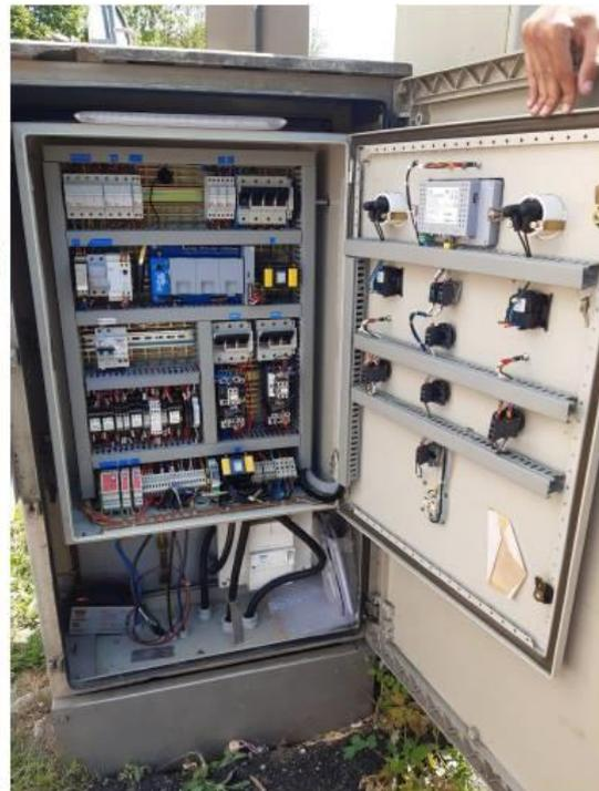
**Figure 128 : Installation d'un sofrel S4W sur le PR (avant/après)**
