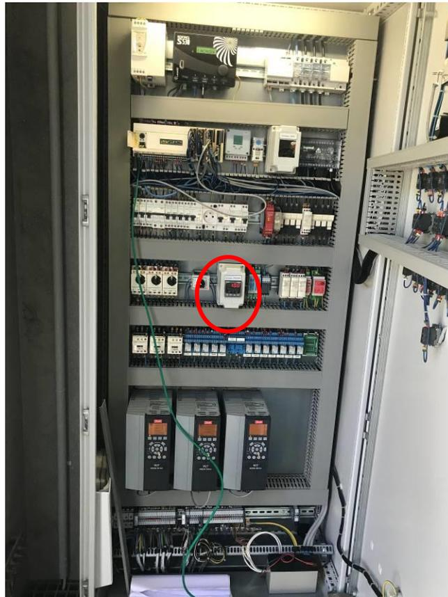
*Figure 50 : Boîtier de régulation*
