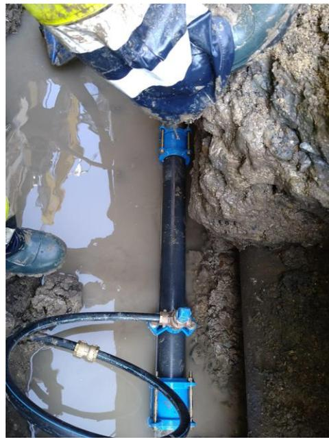
**Figure 66 : Réparation de la conduite - Rue du Moulin – Cauffry**
