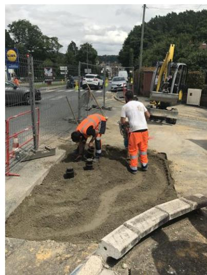
Figure 62 : Pose de vannes – Rue du 1<sup>er</sup> septembre à Cauffry (régie CCLVD)
