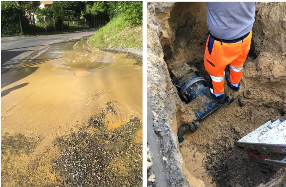
**Figure 45 : Fuite sur la canalisation de production**
