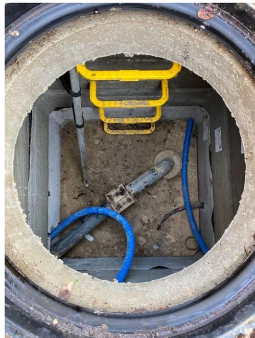
**Figure 139 : Traitement anti H<sub>2</sub>S du PR MARAIS à Labryère**
