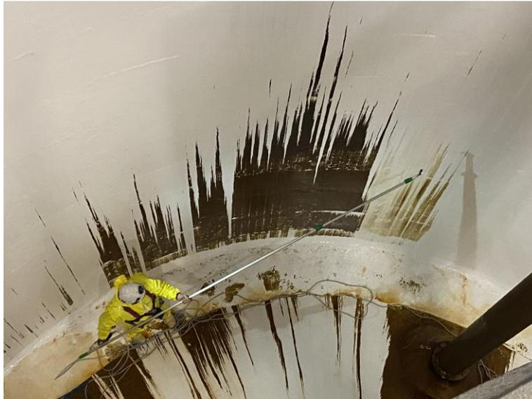
**Figure 44 : Nettoyage mécanique et chimique du réservoir 1500 m<sup>3</sup>**
