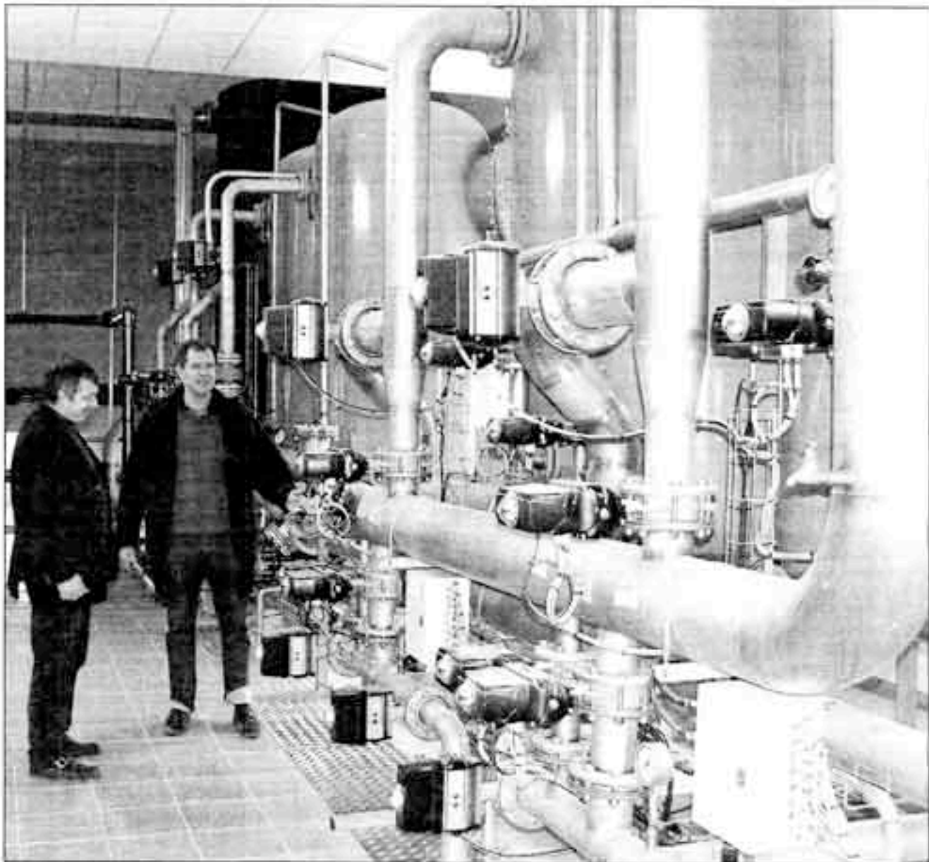
La nouvelle station de captage, à Varesnes. Le puits, profond de 42 mètres, capte une eau de qualité, « mais légèrement ferrugineuse », selon le premier adjoint, François-Xavier Gérard (à gauche). Ouverture prévue en avril.
