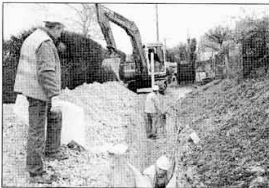
AVRECHY, LUNDI MATIN. Les travaux de raccordement à la station d'assainissement se poursuivent à la sortie d'Avrechy. La polémique sur le prix de l'eau, elle, bat son plein. (L.P./L.M.)
