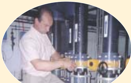
Opérations de maintenance en sous-sol
