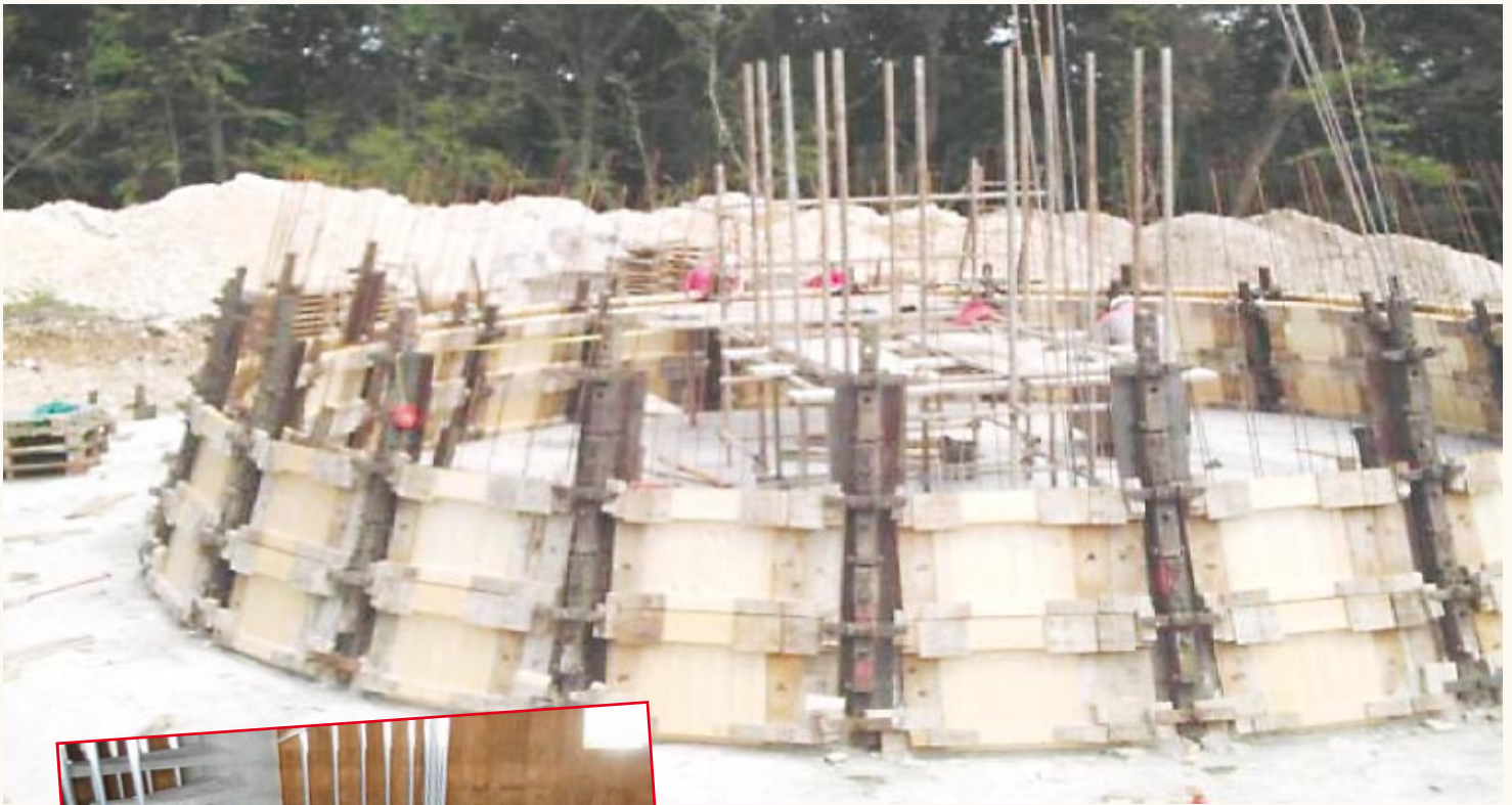
Réservoir sur tour : 1 ère levée
