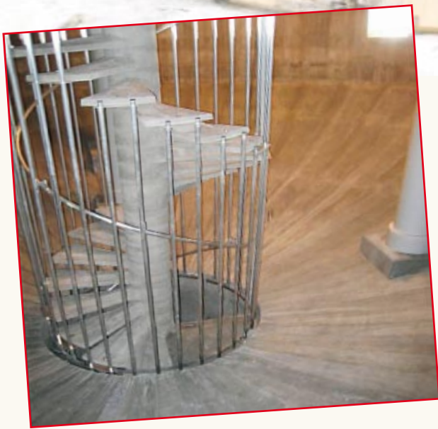
Réservoir sur tour : accès aux cuves
